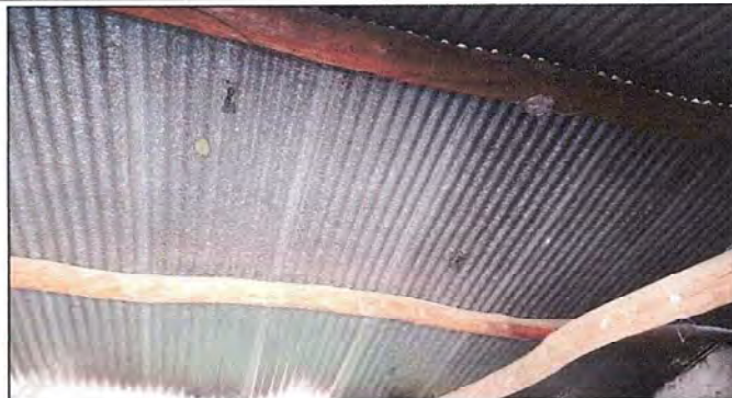
Foto 2: Módulo 1: Sustitución de estructura.
