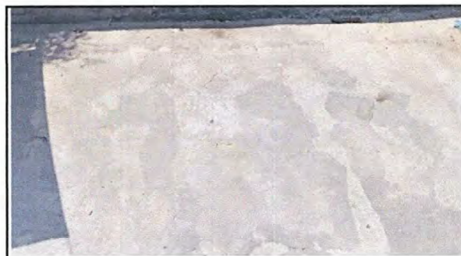
Foto 4: Patio: Sustitución de torta de cemento.
