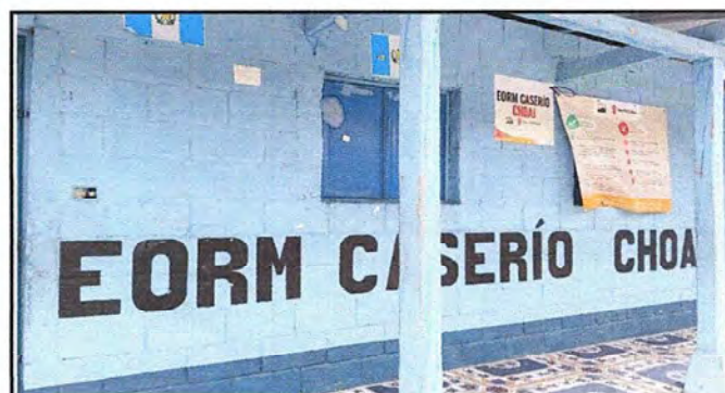
Foto 6: Pintura general: Aplicación de pintura en muros interiores y exteriores
