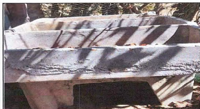
Foto 3: Sustitución de pila de concreto.
