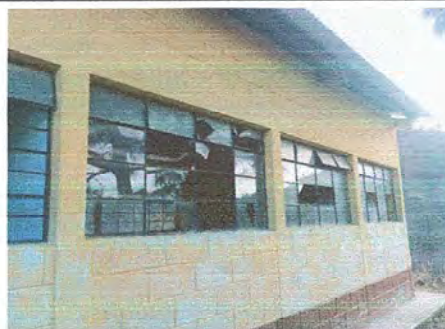
Foto 3: modulo 1 pintura en muros exteriores e interiores
