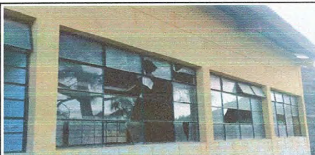
Foto 5: modulo 1 sustitucion de estructura de metal de ventana (incluye vidrios)
