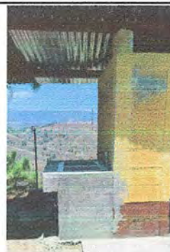
Foto 4: modulo 2 sustitucion de lavamanos
