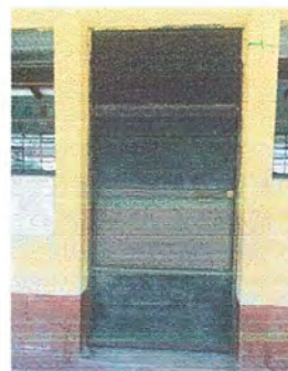
Foto 2: modulo 1 mantenimiento a estructura de puerta lijado cepillado sujeciones, aplicación de pintura.
