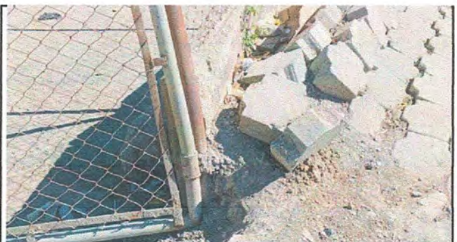
Foto 12: Reparación de muro perimetral de block con tubo HG y malla Galvanizada, soleras intermedias y columnas.
