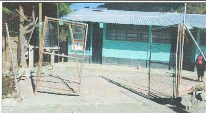
Foto 13: Sustitución de Porton de Metal de tubo HG y malla galvanizada
