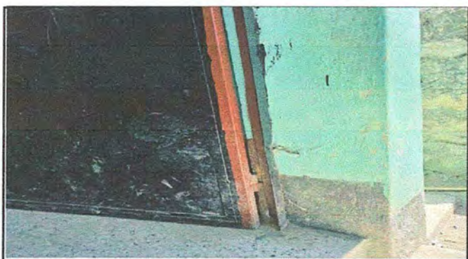
Foto 3: Mantenimiento a Estructura de Puerta MÓDULO 2
