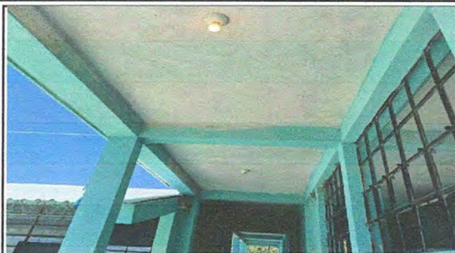
Foto 7: Sustitución de Focos ahorradores MÓDULO 2
