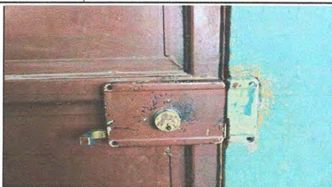
Foto 2: Sustitución de Chapa MÓDULO 2
