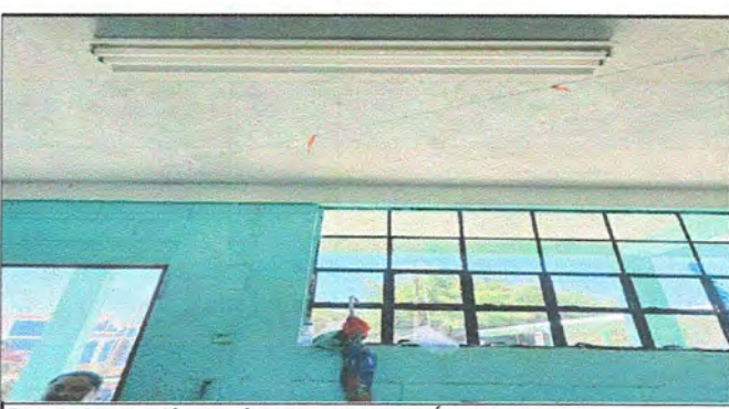
Foto 6: Sustitución de Lámparas de 2x20 MÓDULO 2
