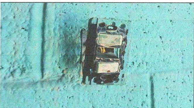
Foto 9: Instalación Unidades de Luz MÓDULO 2
