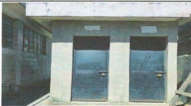
Foto 1: Mantenimiento a Estructura de Puerta de Sanitario MÓDULO 1
