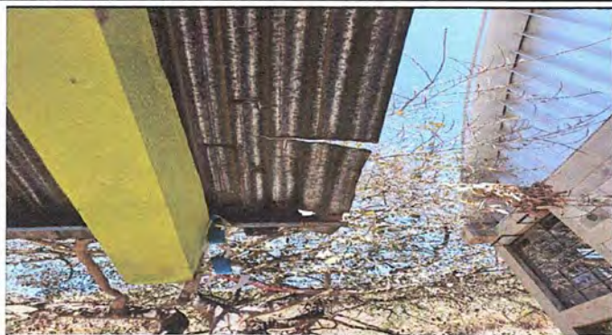
Foto 1: Módulo 1: Sustitución de lámina por lamina troquelada
