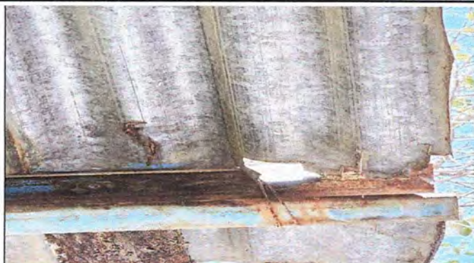
Foto 2: Módulo 1: Sustitución de techo
