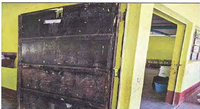
Foto 3: Módulo 1: Mantenimiento a puertas
