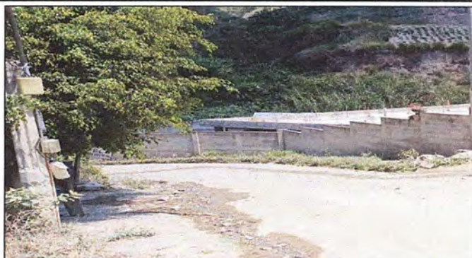
Foto 8: Módulo 2: Pintura en muros interiores y exteriores
