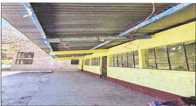
Foto 5: Módulo 1: Instalación de unidades de luz
