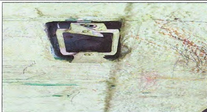
Foto7: Módulo 1: Sustitución de interruptores dobles
