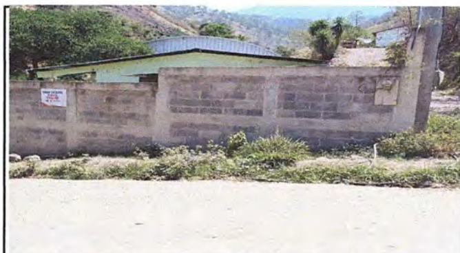
Foto 10: Módulo 1: Pintura en muros interiores y exteriores
