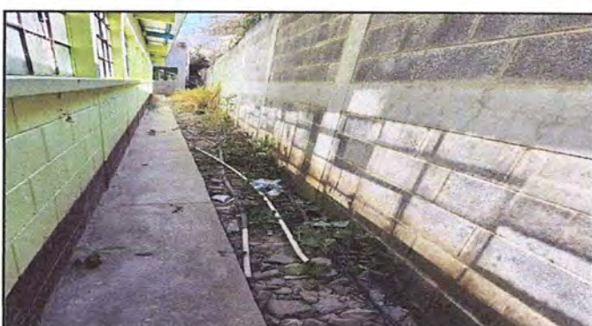
Foto 6: Módulo 2: Mantenimiento a muro exterior e interior
