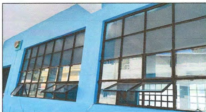
Foto 3: MODULO 1. Suministro e instalación de balcones de metal.
