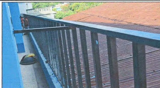
Foto 1: MODULO 1 . Mantenimiento a barandas de metal
