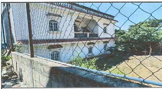
Foto 6: MUROS PERIMETRALES. Reparación de tubo hg y malla galvanizada
