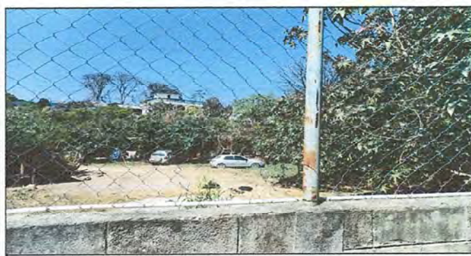
Foto 5: MUROS PERIMETRALES. Reparación de tubo hg y malla galvanizada
