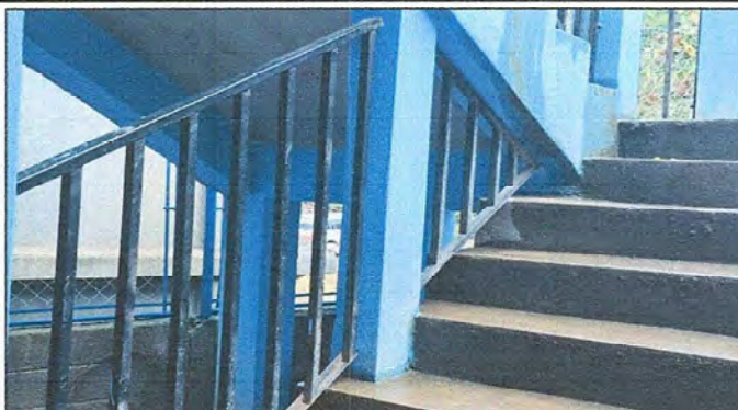
Foto 2: MODULO 1 . Mantenimiento a barandas de metal
