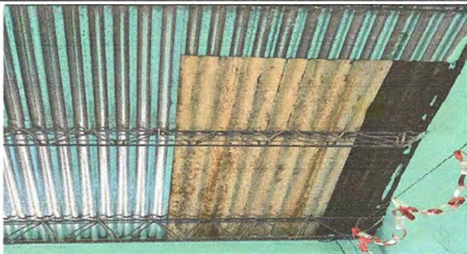
Foto 1: MODULO 1 Sustitución de Lámina, por Lámina troquelada
