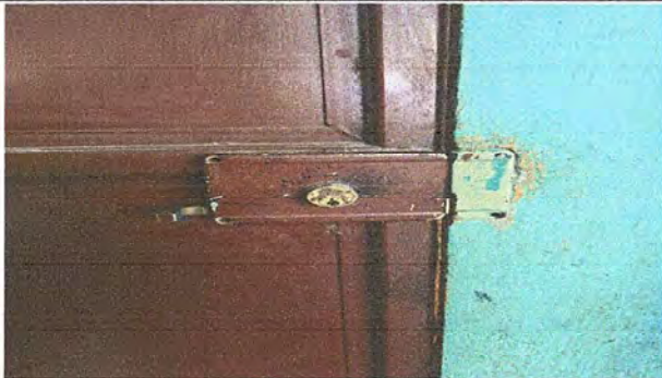
Foto 13: MODULO 1 Sustitución de chapa
