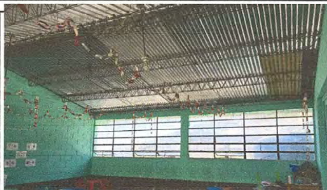
Foto 10: MODULO 1 Reparación de Cableado Eléctrico
