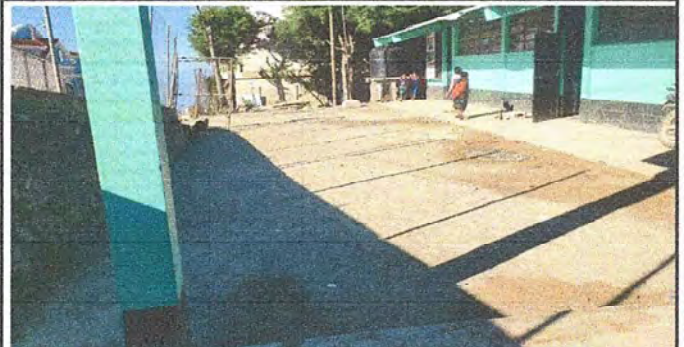
Foto 14: PATIO Reparación de Plancha de concreto de patio
