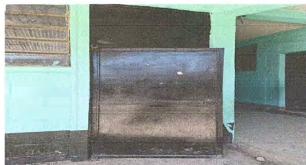
Foto 2: MODULO 1 Mantenimiento a estructura de Puerta
