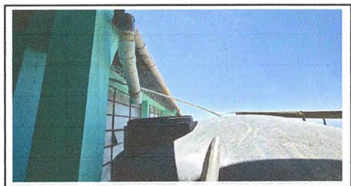
Foto 6: MODULO 1 Reparación de bajada de agua pluvial, tubo PVC 3"
