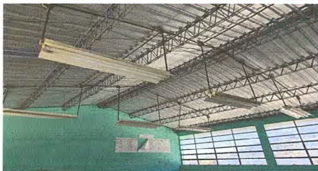
Foto 7: MODULO 1 Sustitución de Lámparas 2x20
