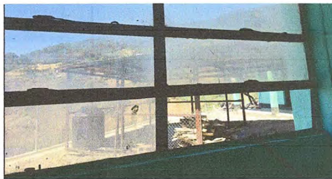
Foto 4: MODULO 1 Sustitución de Vidrios
