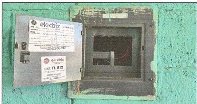
Foto 11: MODULO 1 Sustitución de Tablero de Flipon
