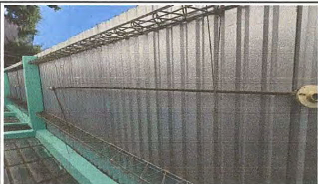
Foto 9: MODULO 1 Sustitución de Ducto Eléctrico
