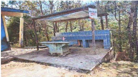
FOTO 9: ÁREAS EXTERIORES: INSTALACIÓN DE PILA
