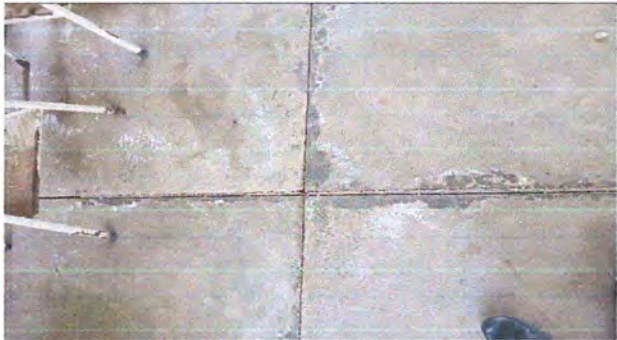
FOTO 1: MODULO 1: SUSTITUCIÓN DE PISO DE CEMENTO LIQUIDO POR PISO CERAMICO
