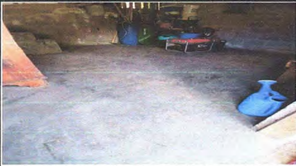
FOTO 7: COCINA: SUSTITUCIÓN DE PISO DE TORTA DE CONCRETO POR PISO CERAMICO
