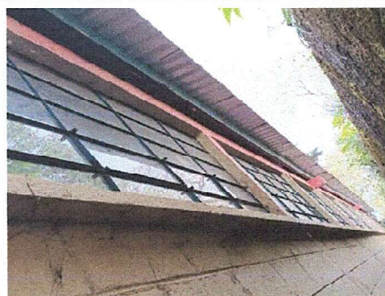
Foto 4: módulo 2: Suministro e instalación de balcón de metal en ventana
