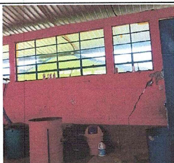
Foto 5: módulo 2: Reparación de pared
