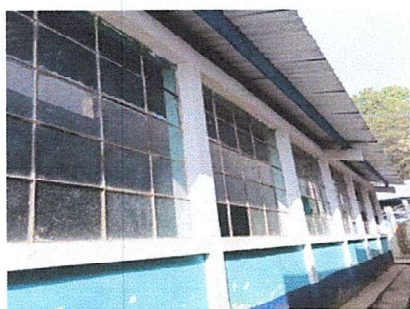
Foto 3: módulo 2: Suministro e instalación de balcón de metal en ventana
