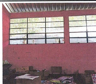
Foto 6: módulo 2: Reparación de pared
