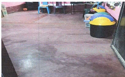
Foto 1: módulo 1: Sustitución de piso de torta de cemento por piso cerámico
