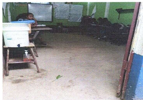
Foto 2: módulo 1: Sustitución de piso de torta de cemento por piso cerámico
