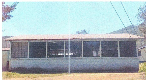
Foto1: Módulo I. Sustitución de lámina, por lámina troquelada aluzinc calibre 26 y Sustitución de capote de lámina para lámina troquelada
