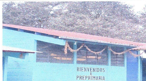
Foto 4: Módulo II, Sustitución de canal de pvc, Sustitución de soporte o pescante para canal y Reparación de bajada de agua pluvial, tubo PVC 3"
