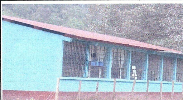
Foto 3: Módulo I, Sustitución de vidrios y Mantenimiento a estructura de metal de ventana
