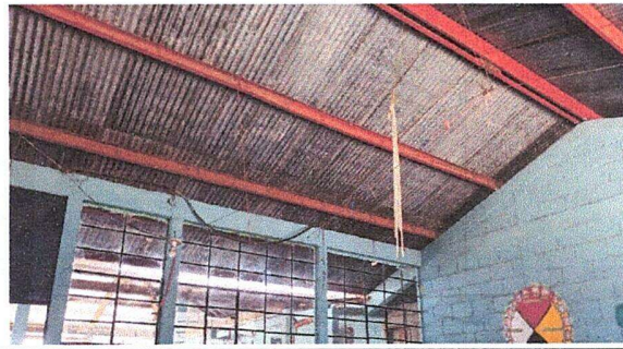
Foto 2: Módulo I, Mantenimiento a estructura de soporte de metal
