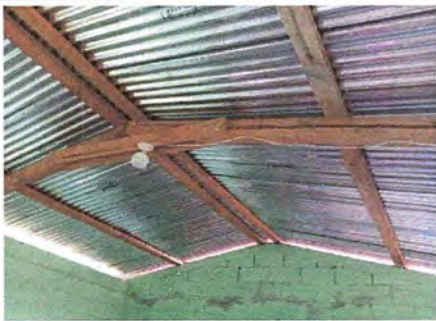
Foto1: Módulo 1: Sustitución de lámina por lámina troquelada
