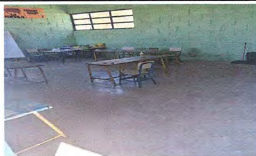
Foto 4: Módulo 1: Sustitución de piso de torta de concreto a piso cerámico
