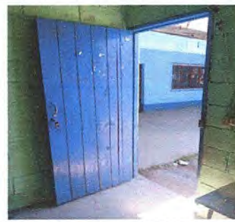
Foto2: Módulo 1: Sustitución de puerta de madera por metal
