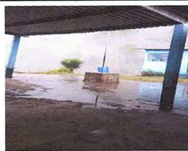
Foto 6: Módulo 1: Reparación de torta de concreto.
