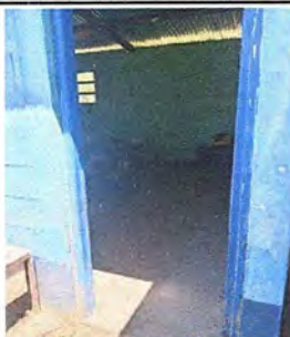
Foto5: Módulo 1: Sustitución de piso de cemento por cerámico.
