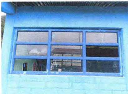
Foto 3: Módulo 1: Sustitución de ventana de madera por metal, más vidrios y balcón.
