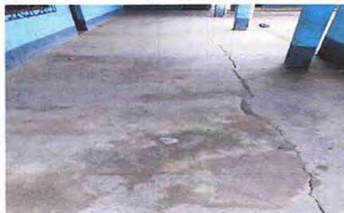
Foto 8: Módulo 2: Sustitución de piso de torta de concreto a piso cerámico
