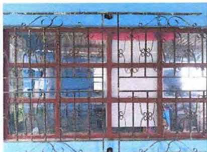
Foto 9: Módulo 2: Mantenimiento a balcón de metal
