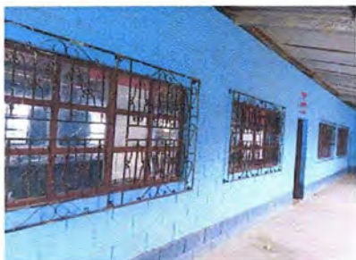
Foto 7: Módulo 2: Sustitución de ventana de madera por metal
