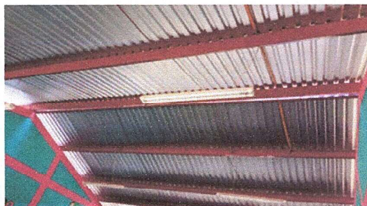
Foto 4: Módulo 2: Repacación de cableado eléctrico
