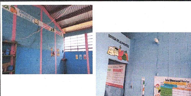
Foto 2: Módulo 1: Sustitución de focos e interruptores
