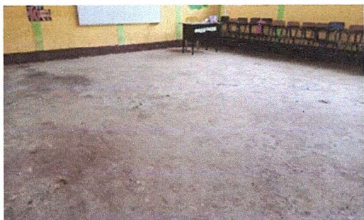
Foto 3: Módulo 2: Sustitución de piso de torta de concreto a piso cerámico
