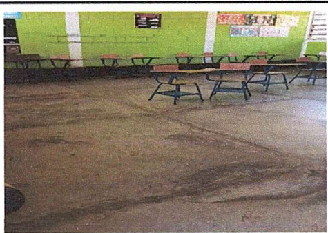
Foto 1: Módulo 1: Sustitución de piso de torta de concreto a piso cerámico
