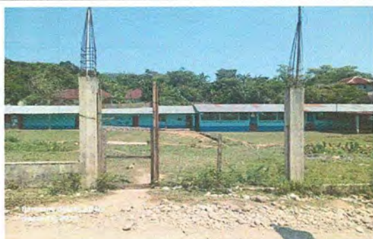
MURO PERIMETRA 1: Fabricacion y colocion de puerton entrada principal
