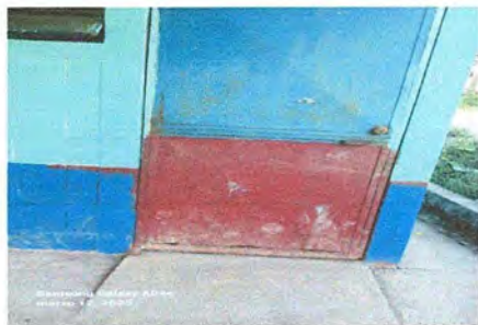
MODULO 1: Fabricacion y sustitucion de puerta de metal
