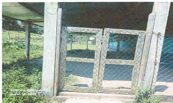
MURO PERIMETRAL 1: Fabricacion y colocacion de porton salida
