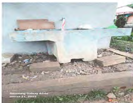
Cocina 1: Sustitucion de pilas plastico de dos lavadera
