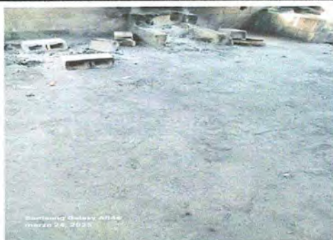
Cocina 1: Sustitucion de pisos a ceramico
