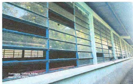
MODULO 1: Sustitucion de vidrios
