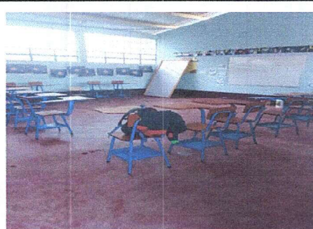
Foto 2: Módulo 1: Sustitución de piso de torta de concreto a piso cerámico
