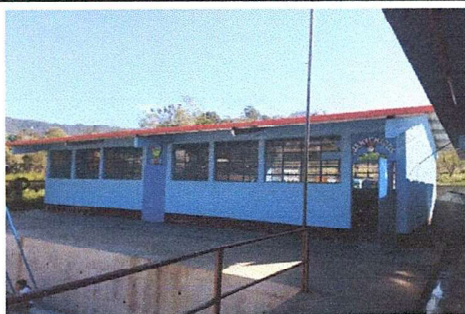
Foto 5: Módulo 3: Sustitución de piso de torta de concreto a piso cerámico
