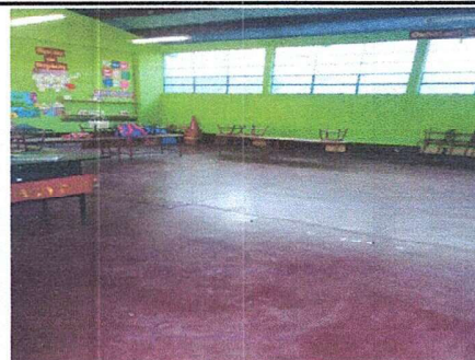
Foto 4: Módulo 2: Sustitución de piso de torta de concreto a piso cerámico
