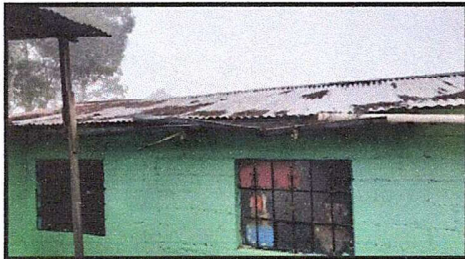
Foto 1: Módulo 1: Sustitución de lámina por lámina troquelada
