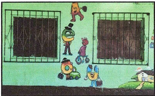
Foto 3: Módulo 1: Suministro e instalación de ventanas de metal
