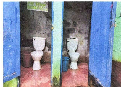
Foto 6: Módulo 2: Sustitución de Inodoro
