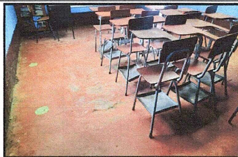
Foto 4: Módulo 1: Sustitución de piso de torta de concreto a piso cerámico
