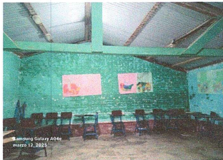
MODULO 1: Sustitucion de piso a ceramico
