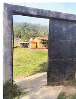
Foto 8: Muro Perimetral, Sustitución de portón
