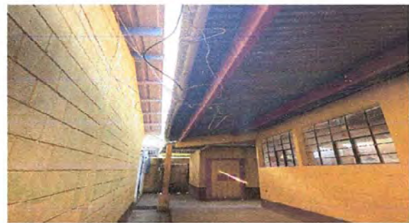
Foto 4: Módulo 1: Reparación del cableado eléctrico
