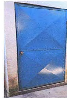
Foto 2: Módulo 1: Mantenimiento a estructura de puertas
