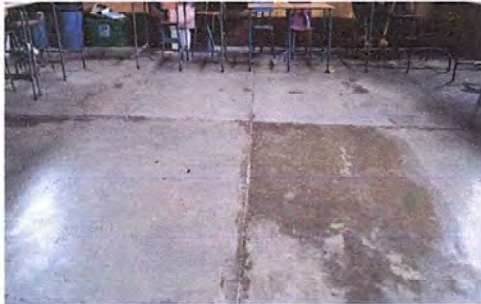
Foto 1: Módulo 1: Sustitución de piso de cemento a piso cerámico
