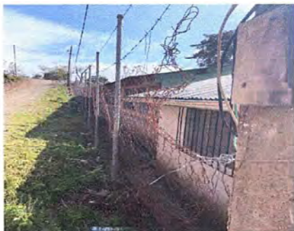
Foto 9: Muro Perimetral, Reparación de tubo hg y malla galvanizada
