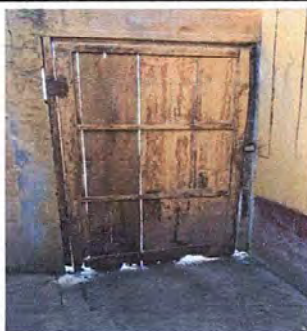
Foto 7: Muro Perimetral, Sustitución de puerta
