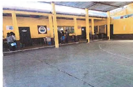
Foto 10: Módulo 2: Mantenimiento a balcones
