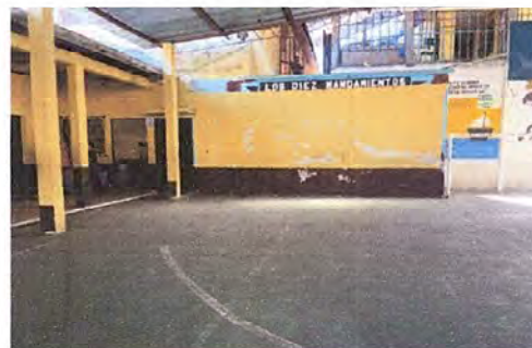
Foto 8: Módulo 2: Pintura en muros exteriores e interiores
