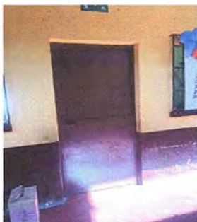
Foto 5: Módulo 1: Mantenimiento a puertas
