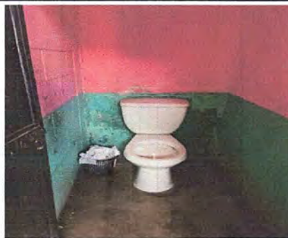
Foto 2: Módulo 1: Sustitución de inodoro
