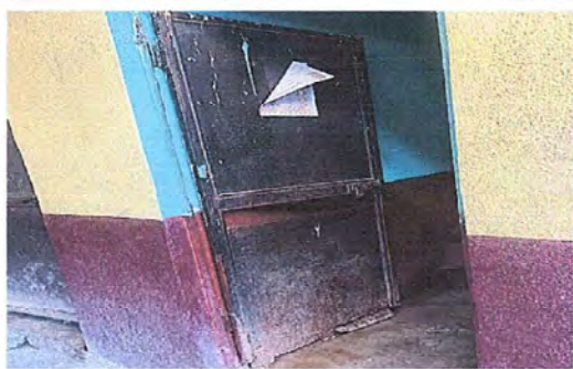
Foto 1: Módulo 1: Sustitución de puerta de metal
