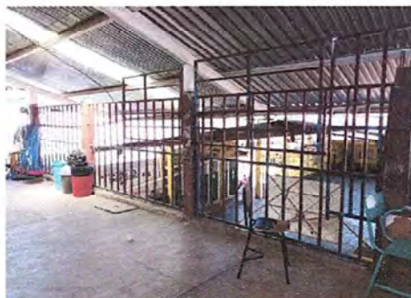
Foto 7: Módulo 1: Mantenimiento a barranda de metal
