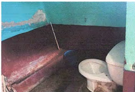
Foto 3: Módulo 1: Suministro e instalación de azulejo
