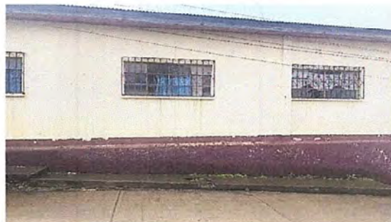
Foto 4: Módulo 1: Mantenimiento a balcones
