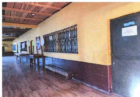
Foto 9: Módulo 2: Mantenimiento a puertas
