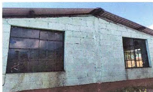
Foto 4: Módulo 1: Sustitución de vidrios e instalación de balcones
