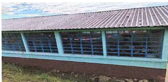
Foto 5: Módulo 2: Sustitución de vidrios
