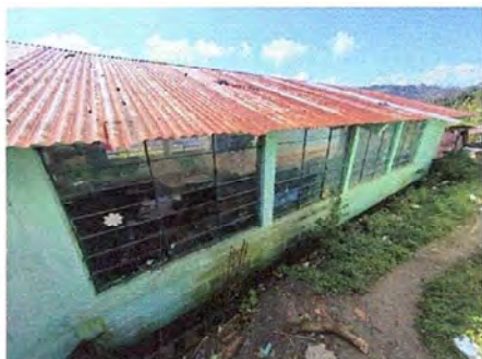
Foto 7: Módulo 3: Sustitución de vidrios
