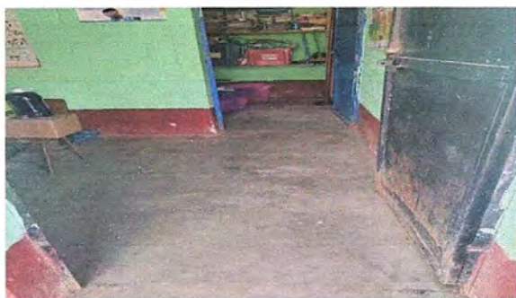
Foto 3: Módulo 1: Sustitución de piso de torta de concreto a piso cerámico
