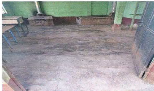
Foto 2: Módulo 1: Sustitución de piso de torta de concreto a piso cerámico
