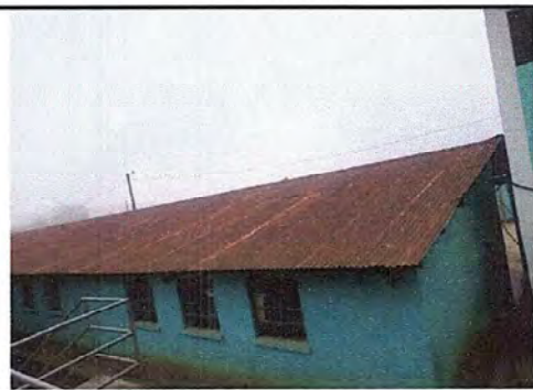
Foto 6: Modulo 1: Situación de lámina a lámiona troquelada calibre 26
