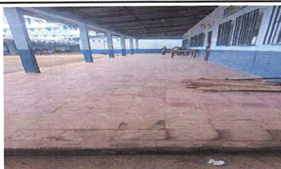
Foto 6: Módulo 4: Sustitución de piso de cemento a piso cerámico
