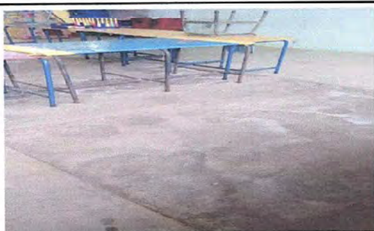
Foto 5: Módulo 4: Sustitución de piso de cemento a piso cerámico
