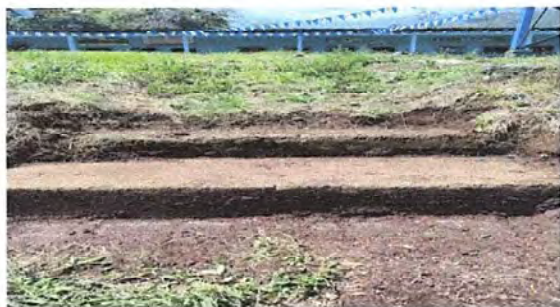
Foto 1: Módulo 1: Reparación de gradas de la entrada
