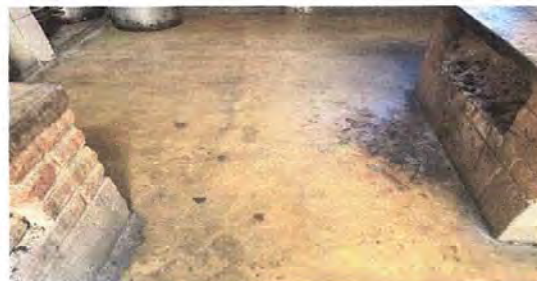
Foto 2: Módulo 2: Sustitución de piso de cemento a piso cerámico
