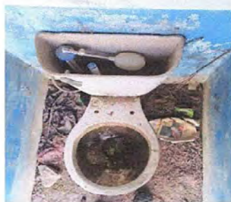
Foto 1: Módulo 1: Sustitución de inodoro
