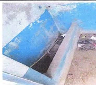
Foto 2: Módulo 1: Reparación de Migitorio
