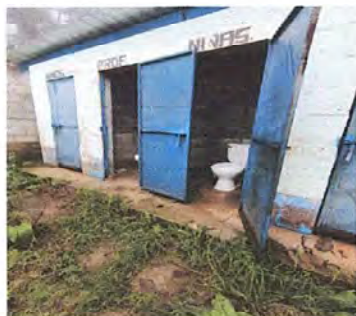
Foto 3: Módulo 1: Mantenimiento a estructura de puerta
