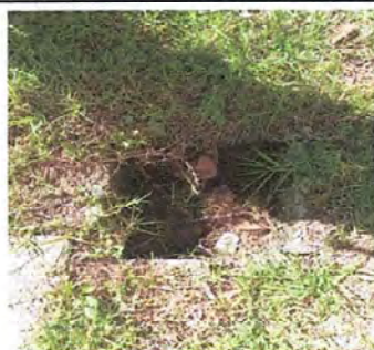
Foto 5: Módulo 1: Sustitución de reposadera
