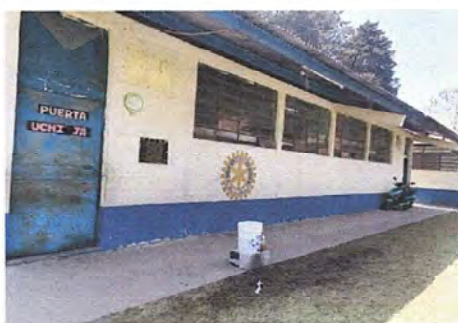
Foto 7: Módulo 3: Mantenimiento a estructura de puerta, suministros e instalación de balcones
