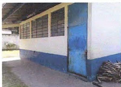
Foto 9: Módulo 4: Mantenimiento a estructura de puerta, suministros e instalación de balcones
