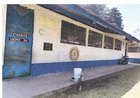
Foto 8: Módulo 3: Pintura en exterior e interior
