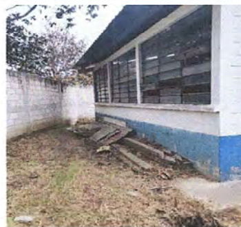
Foto 10: Módulo 4: Pintura en exterior e interior
