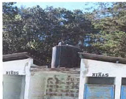
Foto 4: Módulo 1: sustitución de deposito de agua
