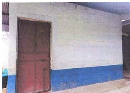
Foto 11: Módulo 5: Mantenimiento a estructura de puerta
