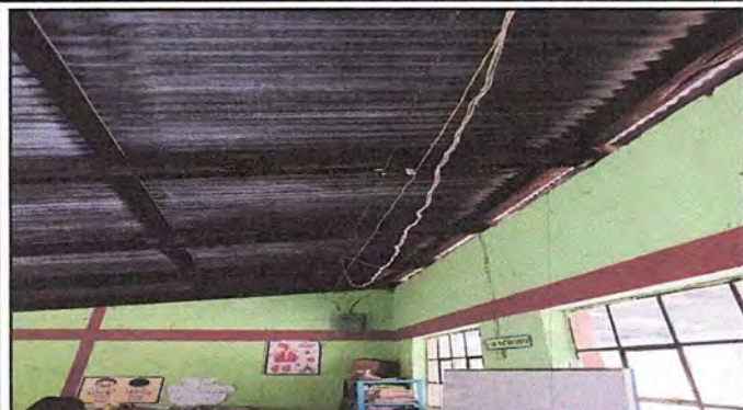
FOTO 13: MODULO I: Sstitución De Ducto Electrico + Accesorios
