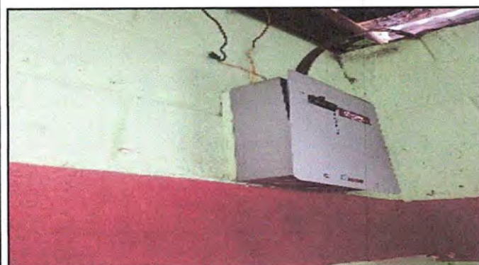
FOTO 11: MODULO I: Sustitución De Tablero De Flipones
