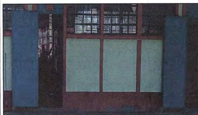
FOTO 15: MODULO II: Mantenimiento a estructura de puerta (lijado, cambio de tubo, cepillado, sujeciones, aplicación de pintura)
