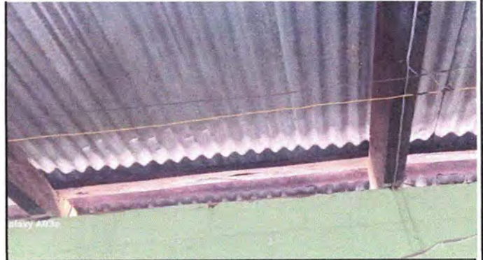
FOTO 2: MODULO 1: Sustitución de estructura de soporte de madera, por metal
