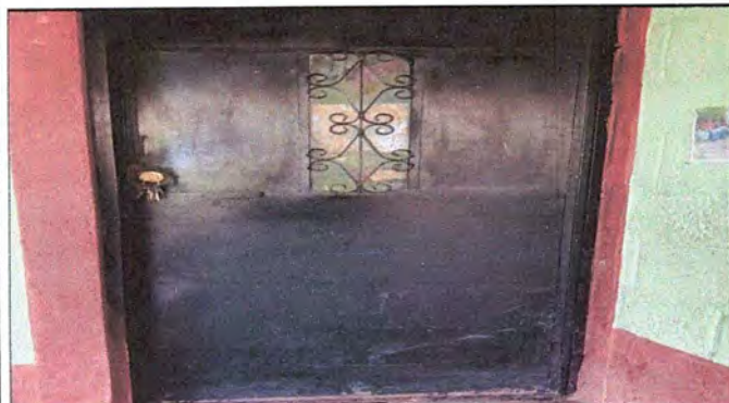
FOTO 5: MODULO 1: Mantenimiento a estructura de puerta (lijado, cambio de tubo, cepillado, sujeciones, aplicación de pintura)
