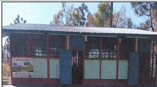
FOTO 14: MODULO II: Pintura en Muros Exteriores e Interiores
