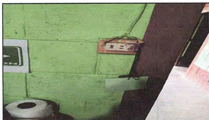
FOTO 9: MODULO I: Sustitución De Tomacorriente Doble
