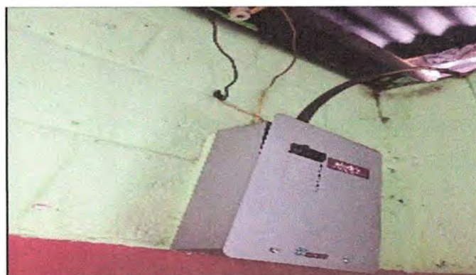
FOTO 10: MODULO I: Sustitución De Flipones
