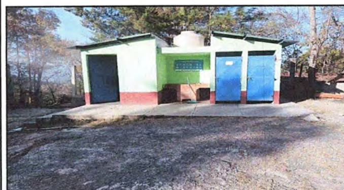
FOTO 17: SANITARIOS: Pintura En Muros Exteriores e Interiores
