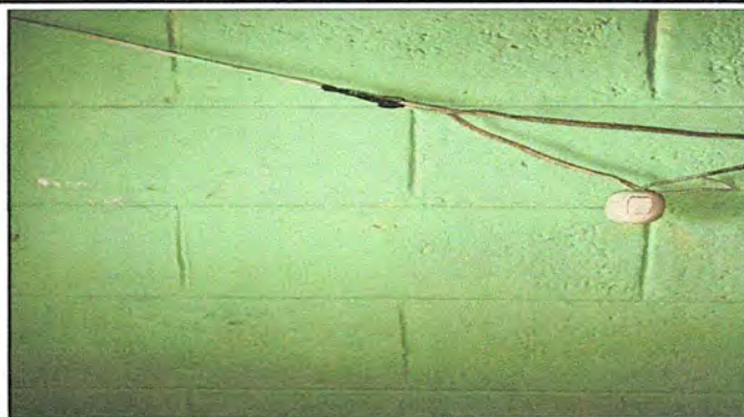
FOTO 8: MODULO I: Sustitución De Interruptor Simple
