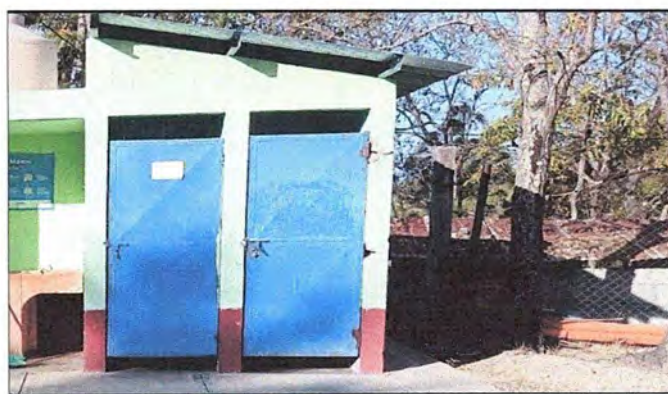
FOTO 16: SANITARIOS: Mantenimiento a estructura de puerta (lijado, cambio de tubo, cepillado, sujeciones, aplicación de pintura)
