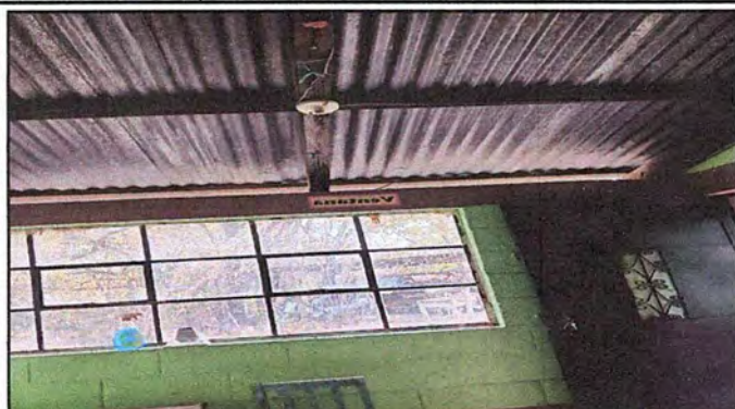
FOTO 7: MODULO I: Sustitución De Plafoneras
