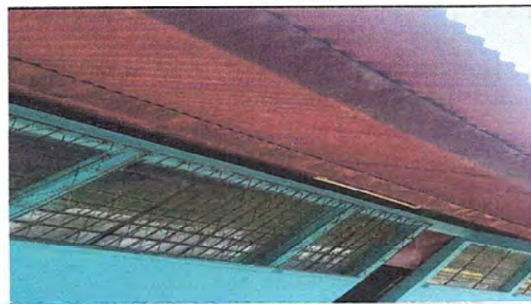
Foto 3: Modulo 2: Mnntenimiento a estructura de soporte de metal
