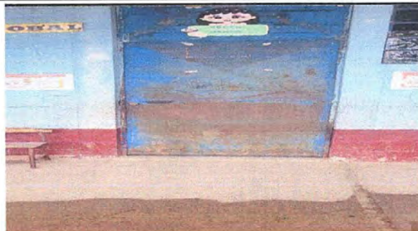
Foto 2: Modulo1: Mantenimiento a estructura de puerta (lijado, cambio de tubo, cepillado, sijeciones)
