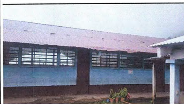
Foto 3: Modulo 2: Sustitución de lámina, por lámina troquelada aluzinc calibre 26
