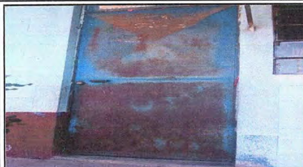
Foto 1: Modulo 1: Sustitución de puerta
