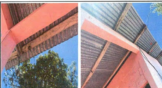
Foto 3 y 4 Modulo I: Sustitución de estructura de soporte de madera, por metal.
