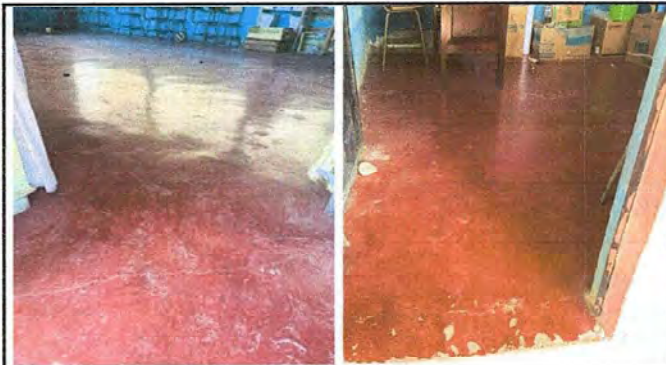
Foto 5 y 6 Modulo I: Sustitución de piso cerámico.
