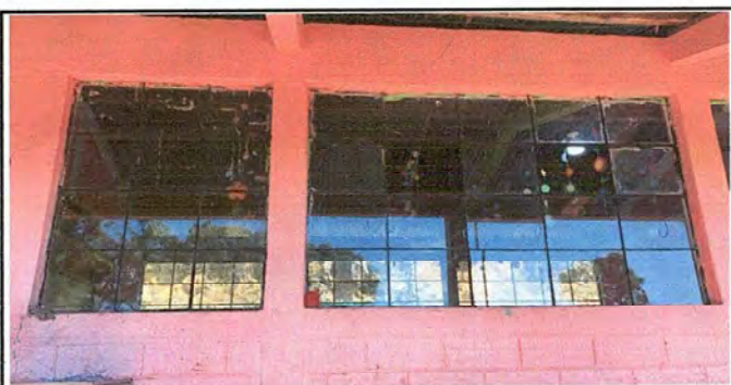
Foto 7 Modulo I: Fabricación e instalación de balcón de hierro en ventanas.
