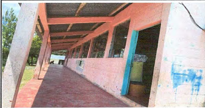
Foto 9 Módulo I: Pintura en muros exteriores e interiores.
