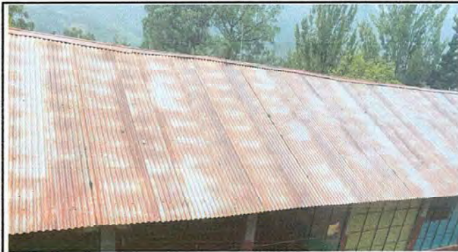
Foto 2 Modulo I: Sustitución de capote de lámina por lámina troquelada.
