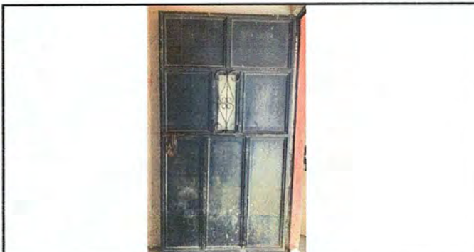
Foto 8 Modulo I: Fabricación e instalación de puerta de metal.
