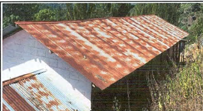
Foto 1 Modulo I: Sustitución de lámina, por lámina troquelada aluzin calibre 26.
