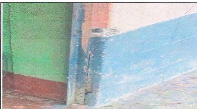
MODULO 2. Pintura en muros interiores y exteriores.
