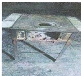
MODULO 3. Sustitucion de estufa rural (completa) incluye chimenea y plancha de metal. Cernidos en muro.
