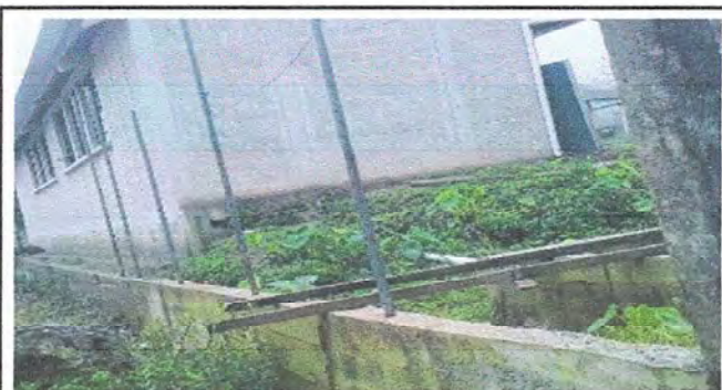
MURO PERIMETRAL. Reparacion de muro perimetral de blok, tubo hg y malla galvanizada.
