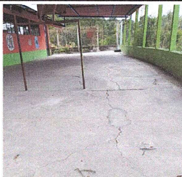
Foto 1: Patio, reparación de Planchas de concreto
