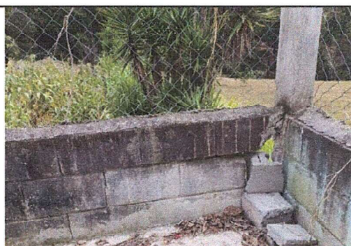
Foto 5: Circulación, Reparación de muro perimetral de block con columnas de concreto, maya galvanizada, soleras intermedias.
