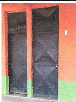
Foto 3: Modulo 1, Sustitución de Puertas
