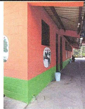
Foto 4: Pintura en muros exteriores e interiores
