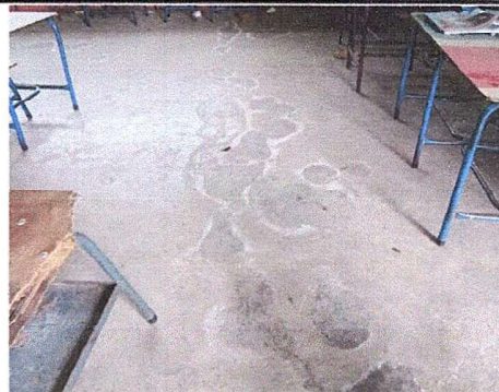
Foto 2: Modulo 1, Sustitución e instalación de piso cerámico
