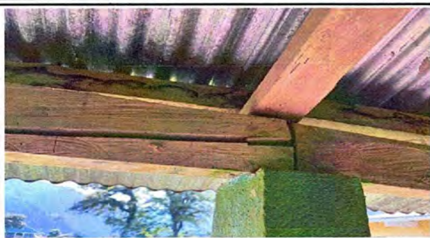
MODULO 2 Sustitución de soporte de madera por metal
