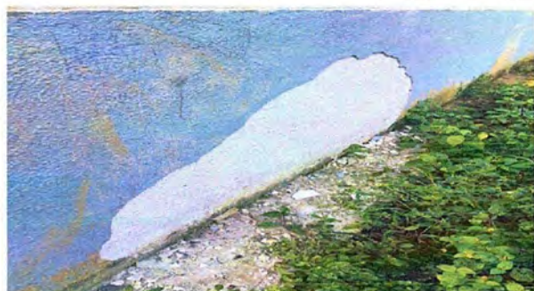
MODULO 1 Repello en muro y cernido en muro
