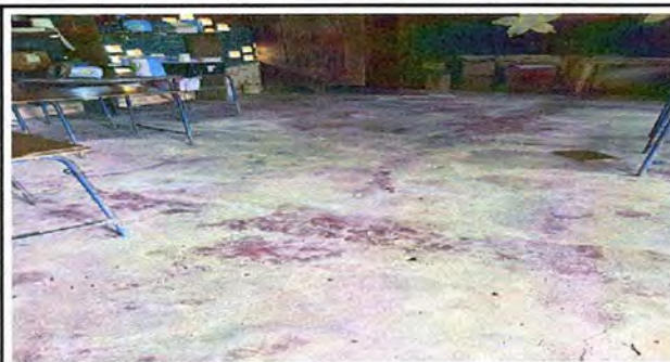
MODULO 2 Sustitución de piso de torta de concreto por piso ceramica
