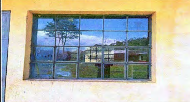
MODULO 1 Suministro e instalación de balcón
