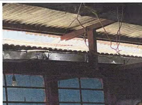
Foto 4: Modulo#1, Reparación de Cableado eléctrico.
