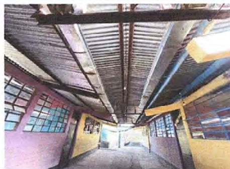
Foto 2: Modulo#1, Suministro e instalación de Balcones de Metal
