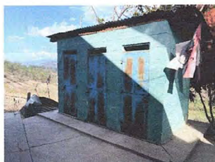
Foto 6: Modulo #3, Sustitución de Lámina, por lámina troquelada aluzinc calibre 26 y sustitución de Capote. Mantenimiento a estructura de Puertas
