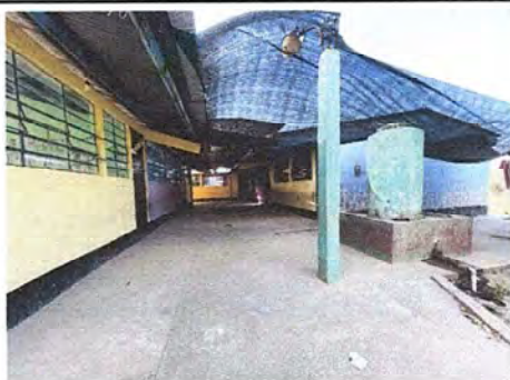
Foto 5: General, Pintura de Muros Interior y exterior.
