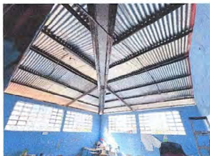
Foto1: Modulo #1, Sustitución de Lámina, por lámina troquelada aluzinc calibre 26 y sustitución de Capote.
