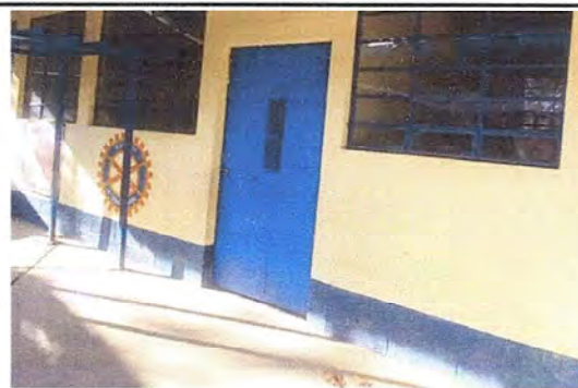
Foto 10: MODULO 3: Mantenimiento a estructura de puerta (lijado, cambio de tubo, cepillado, sujeciones, aplicación de pintura)
