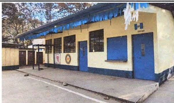
Foto 9: MODULO 3: Suministro e instalación de balcones de metal
