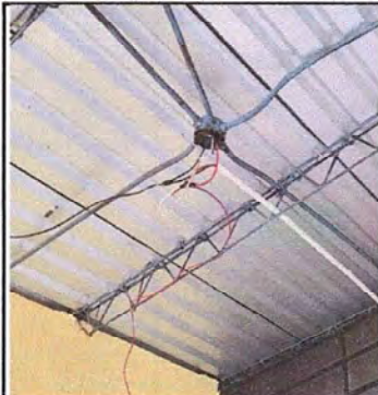
Foto 1: MODULO 1: Instalación de unidades luz (incluye interruptor, ducto y cable eléctrico)
