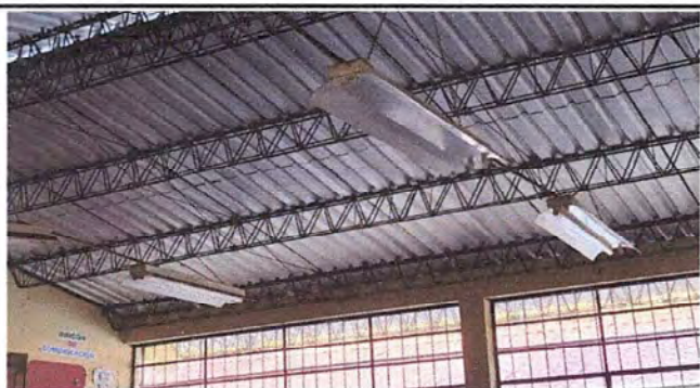
Foto 3: MODULO 1: Sustitución de lámparas tipo LED
