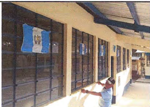
Foto 7: MODULO 2: Suministro e instalación de balcones de metal
