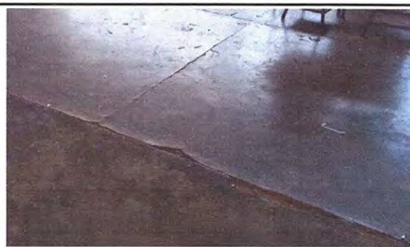
Foto 4: MODULO 1: Sustitución de piso de torta de concreto
