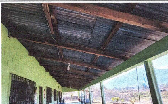
Foto 3: MODULO 1: Instalación de estructura portante de metal
