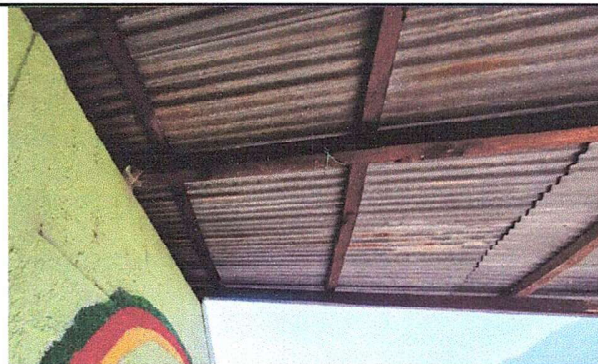
Foto 2: MODULO 1: Sustitución de elementos de fijación (tornillos)
