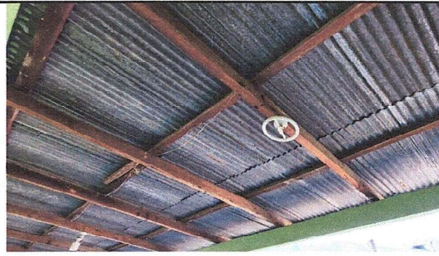
Foto 4: MODULO 1: Sustitución de estructura de soporte de metal, por metal
