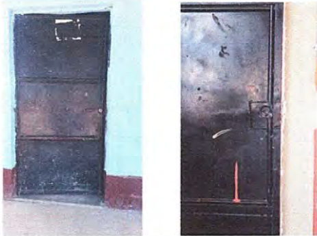
Foto 7: MODULO 2: Sustitución de chapa
