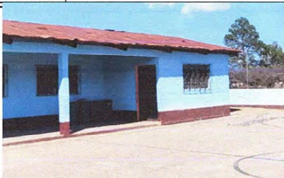
Foto1: MODULO 1:Sustitución de lámina, por lámina troquelada aluzinc calibre 26
