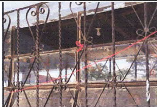
Foto 4: MODULO 1: Sustitución de vidrios
