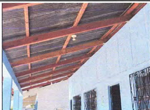
Foto 3: MODULO 1: Mantenimiento a estructura de soporte de metal
