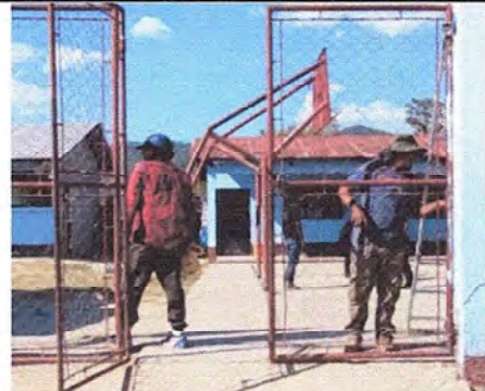
Foto 8: Suministro e instalación de portones de metal
