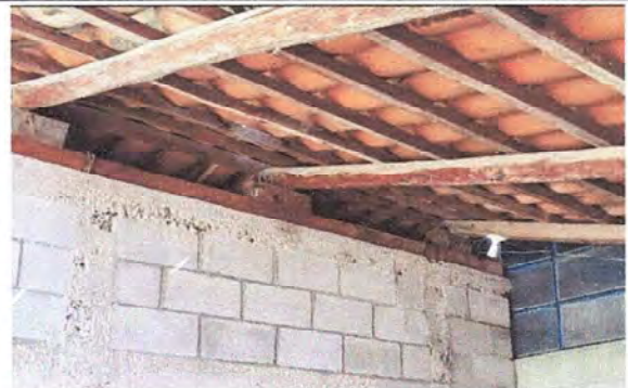
Foto 2: MODULO 2: COCINA: Sustitución de lámina, por lámina troquelada aluzinc calibre 26
