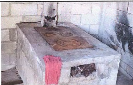
Foto 5: MODULO 2. COCINA: Sustitución de plancha de metal de 3 hornillas
