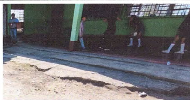
Foto 8: LOMA DE PATIO: Reparación de planchas de concreto de patio
