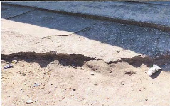
Foto 7: LOMA DE PATIO: Reparación de planchas de concreto de patio
