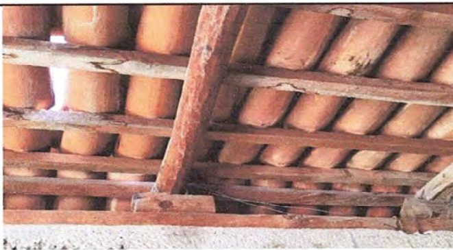
Foto 3: MODULO 2: COCINA: Sustitución de estructura portante de metal
