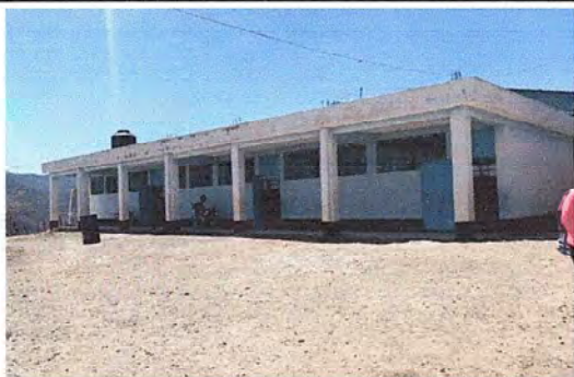
Foto 9: PINTURA GENERAL: Pintura en muros exteriores e interiores
