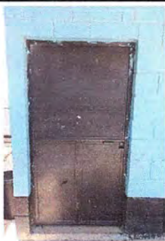
Foto 1: MODULO 1: Mantenimiento a estructura de puerta (lijado, cambio de tubo, cepillado, sujeciones, aplicación de pintura)
