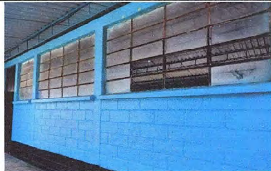
Foto 2: MODULO 1: Sustitución de vidrios y Suministro e instalación de balcon de metal
