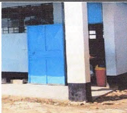
Foto 7: MODULO 4: Sustitución de chapa y Mantenimiento a estructura de puerta (lijado, cambio de tubo, cepillado, sujeciones, aplicación de pintura)
