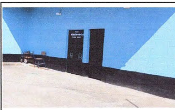
Foto 4: MODULO 2: Mantenimiento a estructura de puerta (lijado, cambio de tubo, cepillado, sujeciones, aplicación de pintura) y Sustitución de chapa
