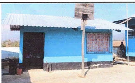
Foto 5: MODULO 3: Mantenimiento a estructura de puerta (lijado, cambio de tubo, cepillado, sujeciones, aplicación de pintura) y Suministro e instalación de ventana de metal
