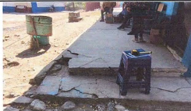
Foto 10: MODULO 2: Sustitución de piso de torta de concreto.
