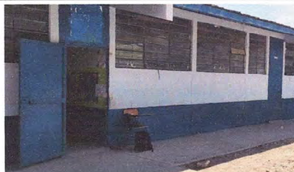
Foto 4: MODULO 1: Mantenimiento a estructura de puerta (lijado, cambio de tubo, cepillado, sujeciones, aplicación de pintura)
