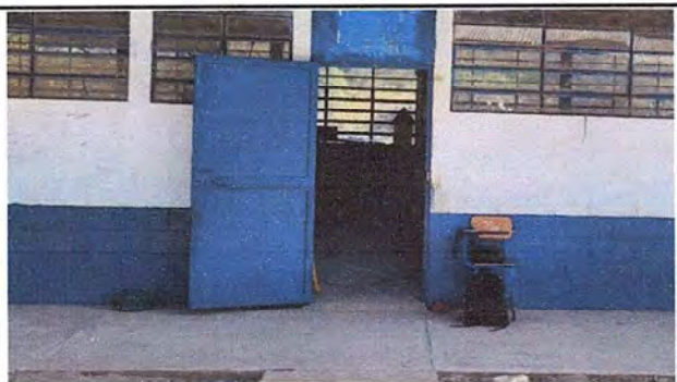
Foto 5: MODULO 1: Sustitución de chapa
