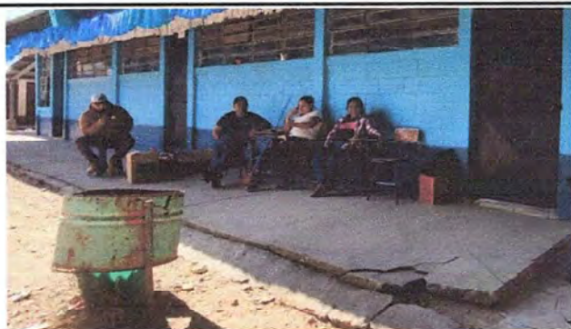
Foto 9: MODULO 2: Sustitución de piso de torta de concreto.
