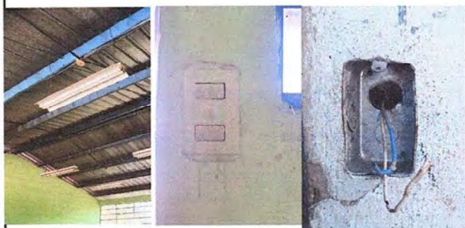
Foto 3: MODULO 1: Instalacion de unidades luz (Incluye interruptor, ducto y cable eléctrico)
