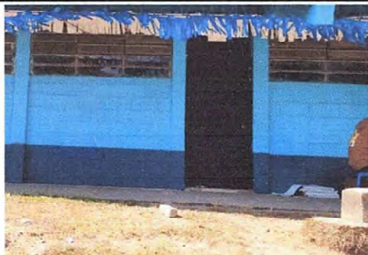
Foto 7: MODULO 2: Mantenimiento a estructura de puerta (lijado, cambio de tubo, cepillado, sujeciones, aplicación de pintura)
