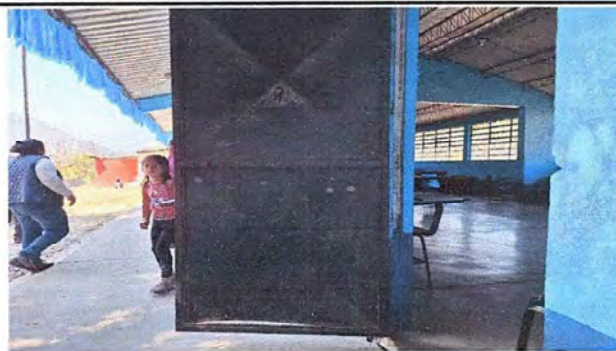
Foto 6: MODULO 2: Sustitución de puerta de metal
