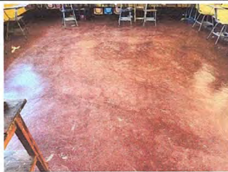
Foto 2: Modulo #1, Sustitucion de Piso de Torta de Concreto Por Piso Ceramico.
