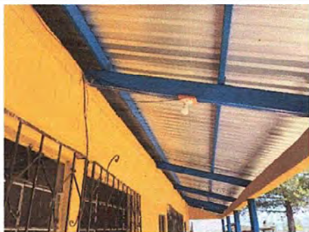
Foto 7: Modulo #1, Sustitucion de Focos Ahorradores
