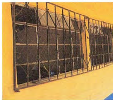
Foto 10: Modulo #1, Sustitucion de Vidrios en Ventanas de Metal
