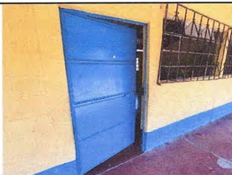
Foto 3: Modulo#1, Mantenimiento de Estructura de Puerta y Cambio de Cahapa.
