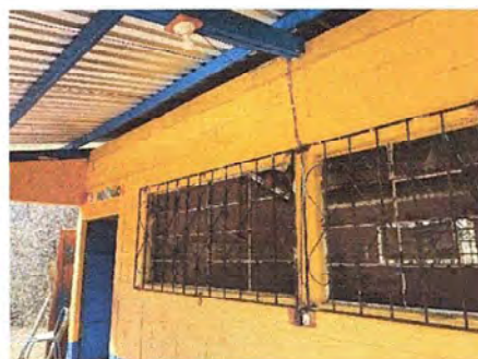
Foto 4: Modulo#1, Sustitucion de Ventanas de Metal por PVC mas Vidrios.
