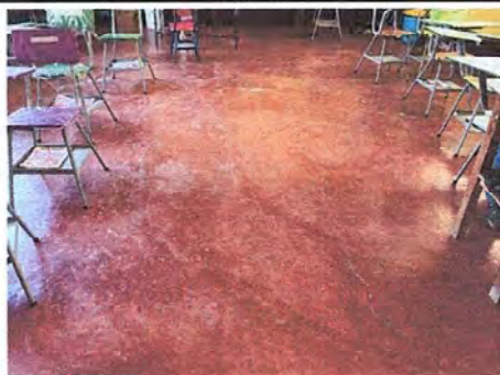
Foto 1: Modulo #1, Sustitucion de Piso de Torta de Concreto Por Piso Ceramico.
