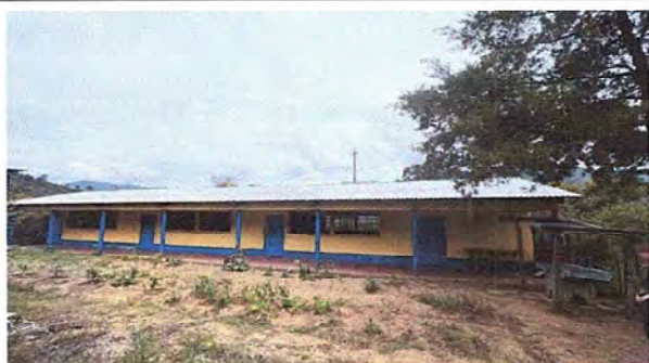
Foto 9: General, Pintura en Muros Exteriores.
