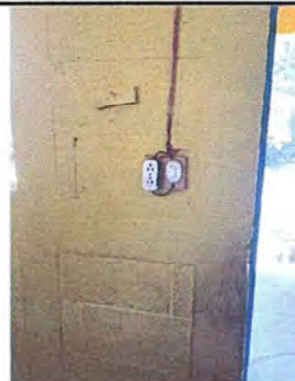
Foto 8: Modulo#1, Sustitucion de Toma Corrientes Dobles
