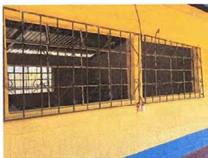
Foto 5: Modulo #1, Sustitucion de Balcones de Metal.
