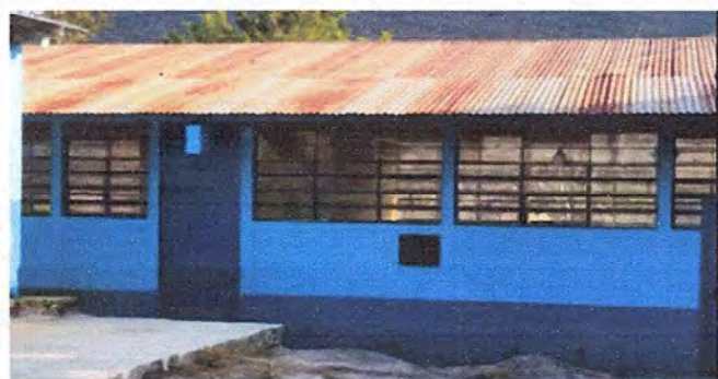
Foto1: MODULO 1: Sustrucción de lámina, por lámina troquelada aluzinc calibre 26
