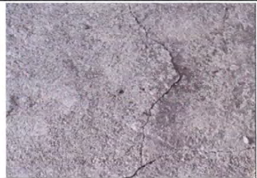
Foto 10: MODULO 3: Sustitución de piso de torta de concreto
