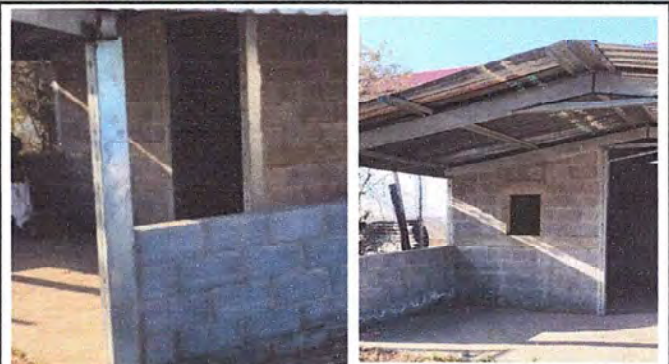
Foto 8: MODULO 3: Suministro e instalación de puerta de metal
