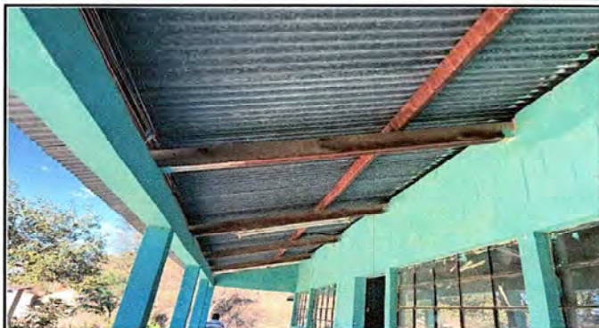
Foto 2: Modulo 1: Corredor. Mantenimiento a estructura portante.
