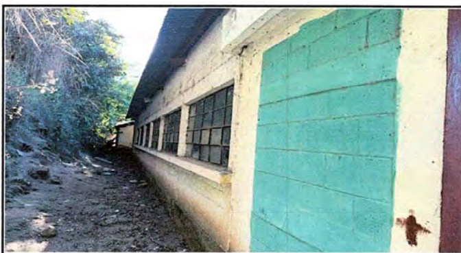
Foto 4: Pintura interior y exterior en modulo 1 y baños
