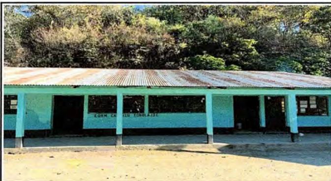
Foto1: Modulo 1: Sustitución de lamina en mal estado por lamina troquelada aluzic calibre 26"
