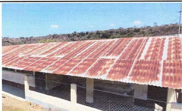
Foto 3: MODULO 1: Sustitución de capote de lámina para lámina troquelada
