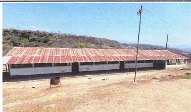
Foto 1: MODULO 1: Sustitución de lámina, por lámina troquelada aluzinc calibre 26
