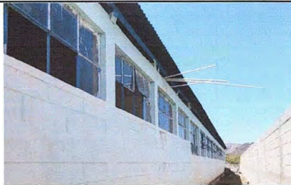
Foto 4: MODULO 1: Sustitución de vidrios
