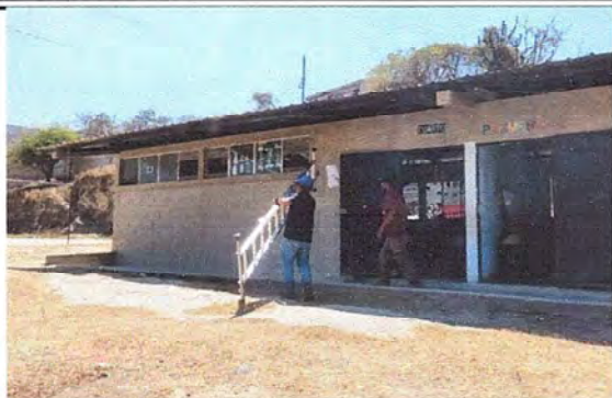
Foto 7: MODULO 2: Suministro e instalación de balcones de metal
