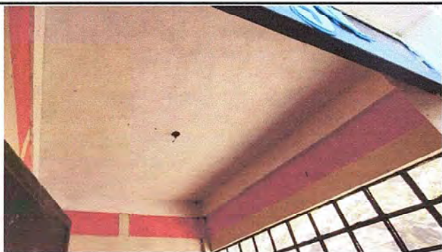
Foto 1: MODULO 1. Instalación de unidades luz (incluye interruptor, ducto y cable eléctrico)
