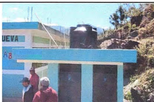
Foto 11: MODULO 2: Sustitución de depósito de agua 1100 lt
