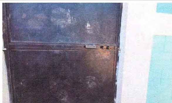
Foto 3: MODULO 1: Mantenimiento a estructura de puerta (lijado, cambio de tubo, cepillado, sujeciones, aplicación de pintura)
