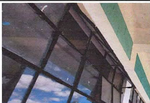
Foto 5: MODULO 1: Sustitución de vidrios
