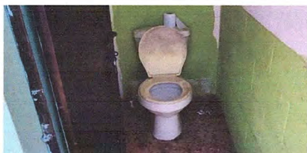
Foto 9: MODULO 2: BAÑOS: Sustitución de accesorios inodoro (contra llave, tubo de abasto y tanque)
