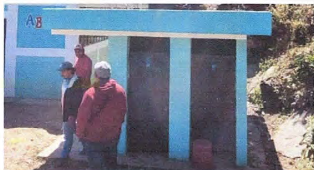
MODULO 7: BAÑOS: Instalación de unidades luz (incluye interruptor, ducto y cable eléctrico)
