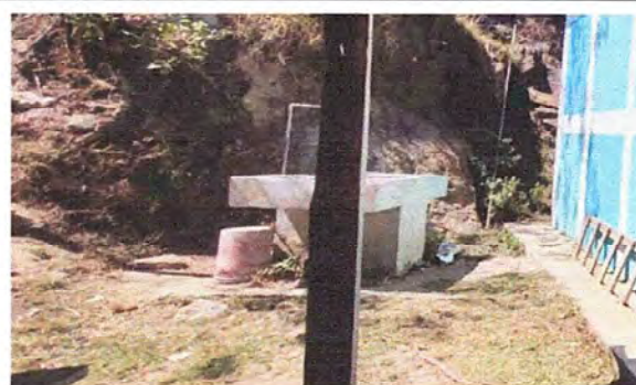
Foto: 8: MODULO 2 :Sustitución de pila de cemento de un lavadero
