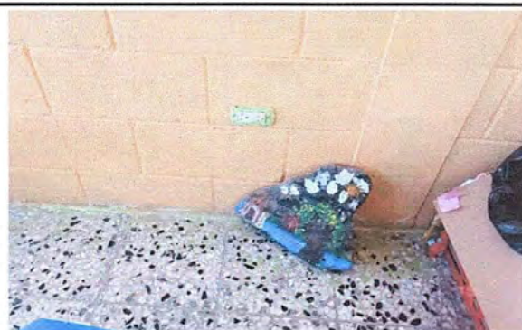
Foto 2: MODULO 1: Sustitución de tomacorrientes dobles
