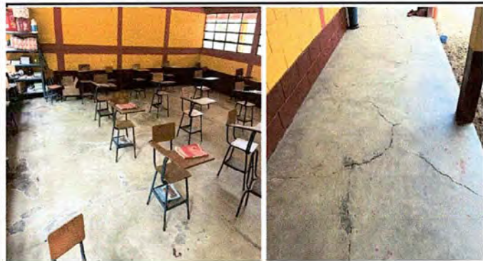
Foto 1: Modulo 1: Sustitución de piso de cemento por piso ceramico en aulas, corredor, direccion, bodega y baños.
