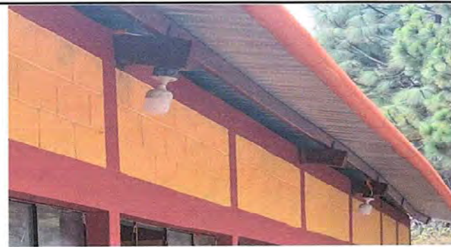
Foto 4: Modulo 1: Sustitución de foco ahorrador
