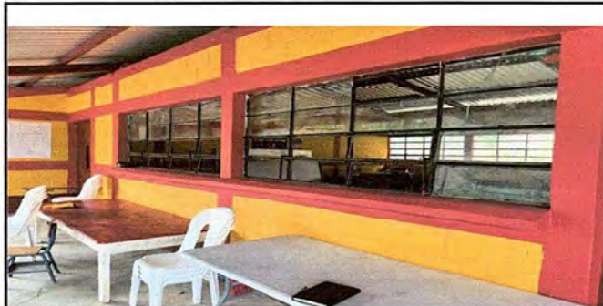
Foto 2: Modulo 1: Suministro e instalación de balcones de metal en ventanas
