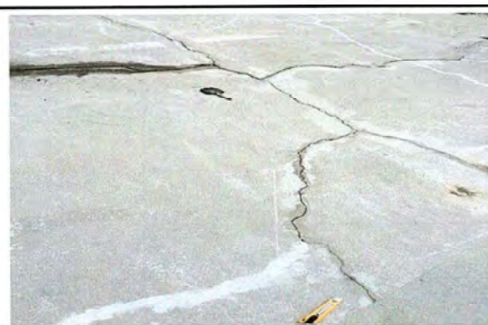
Foto 6: Patio: Reparación de planchas de concreto de patio
