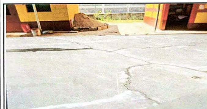
Foto 5: Patio: Reparación de planchas de concreto de patio
