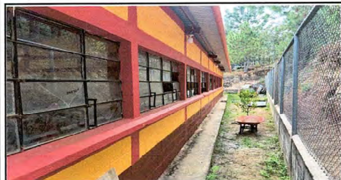
Foto 3: Modulo 1: Sustitución de vidrios.
