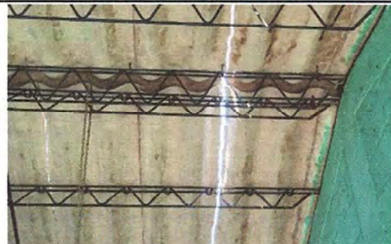
Foto 2: MODULO 1: Sustitución de estructura de soporte de metal, por metal
