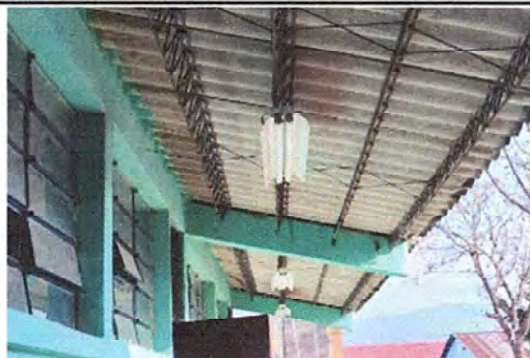
Foto 3: MODULO 1: Sustitución de elementos de fijación (tornillos)
