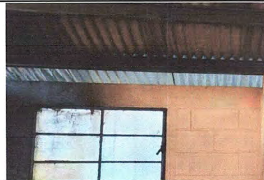
Foto 10: MODULO 2: Mantenimiento a estructura de soporte de metal
