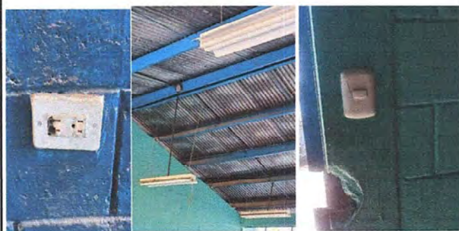
Foto 4: MODULO 1: Sustitución de lamparas tipo LED, sustitucion de tomacorrientes e interruptores
