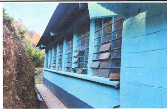
Foto 6: MODULO 1: Suministro e instalación de balcones de metal
