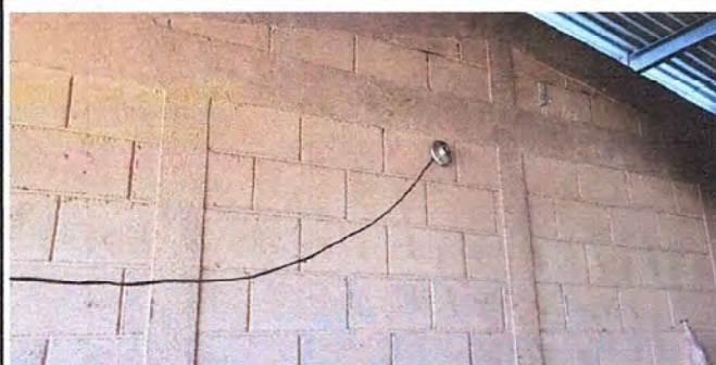
Foto 13: MODULO 2: Sustitución de lamparas tipo LED
