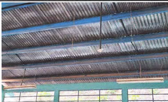
Foto 1: MODULO 1: Sustitución de lámina, por lámina troquelada aluzinc calibre 26
