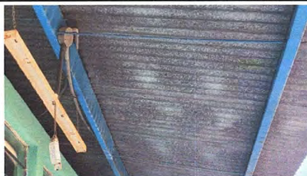
Foto 2: MODULO 1: Sustitución de elementos de fijación (tornillos)
