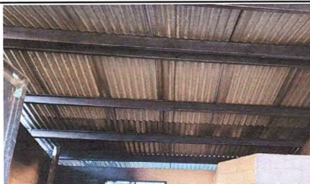
Foto 9: MODULO 2: Sustitución de lámina, por lámina troquelada aluzinc calibre 26
