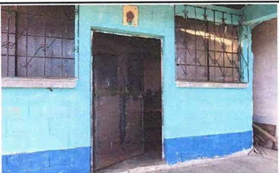
Foto 11: MODULO 2: Mantenimiento a estructura de puerta (lijado, cambio de tubo, cepillado, sujeciones, aplicación de pintura)
