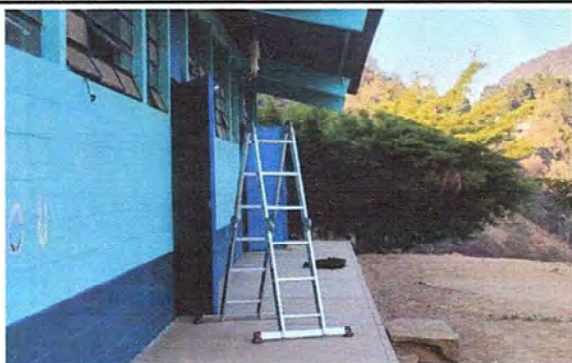
Foto 7: MODULO 1: Mantenimiento a estructura de puerta (lijado, cambio de tubo, cepillado, sujeciones, aplicación de pintura)
