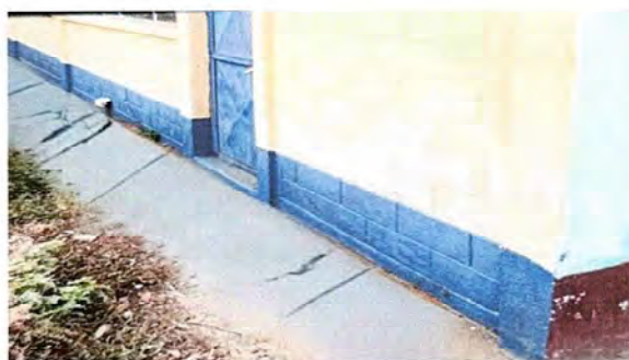
Foto 6: Modulo 1: Reparación de banqueta de concreto.
