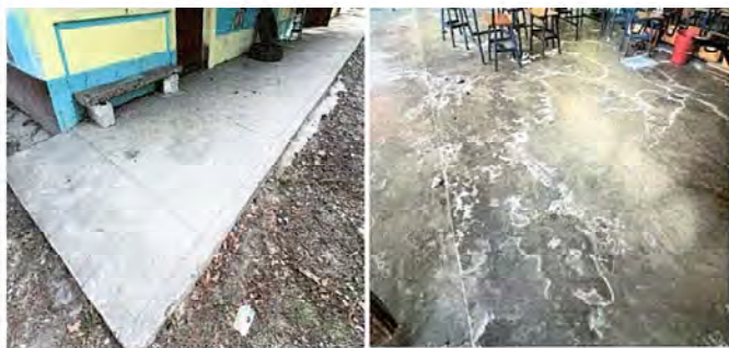
Foto1: Modulo 1: Sustitución de piso de cemento en aulas, cocina, corredor y bodega por piso ceramico
