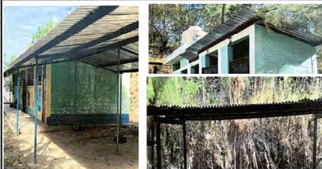
Foto 2: Modulo 1, 2 y 3: mantenimiento a estructura portante.
