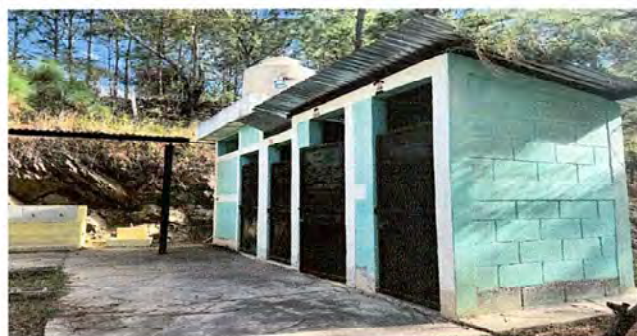
Foto 10: Módulo 2: Sustitución de lamina por lamina troquelada calibre 26"
