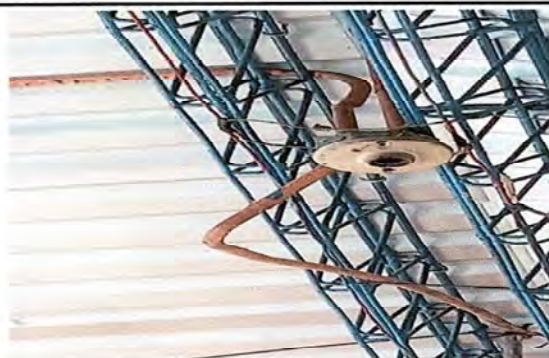
Foto 9: Módulo 1: Reparación de cableado eléctrico.
