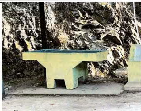
Foto 7: Módulo 3: Sustitución de pila
