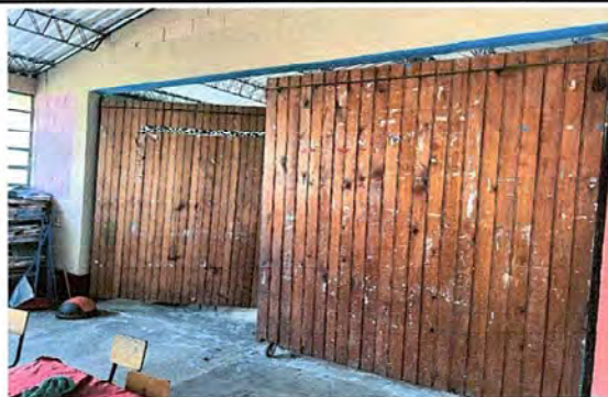
Foto 4: Modulo 1: Reparación de muro divisor
