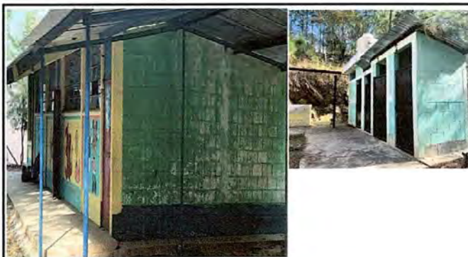
Foto 8: General: Pintura Interior y Exterior en todos los módulos.
