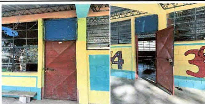
Foto 3: Modulo 1: Mantenimiento a puertas de metal repación, lijado y pintado en todos los modulos
