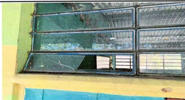
Foto 5: Modulo 1: Sustitución de vidrios.
