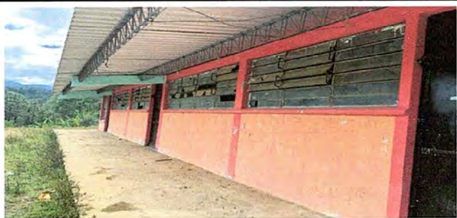
Foto 5: Modulo 1: Suministro e Instalación de balcones de metal en ventanas
