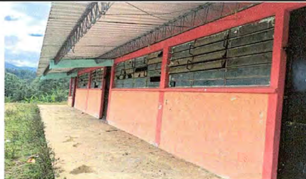
Foto 2: Modulo 1: sustitución de vidrios en mal estado
