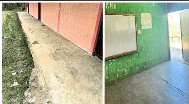
Foto1: Modulo 1: Sustitución de piso de cemento por piso ceramico en aulas, cocina, bodega y corredor.
