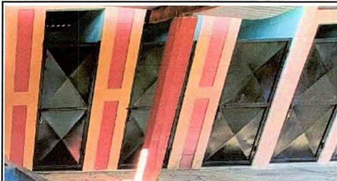
Foto 7: Modulo 2: Mantenimiento a puertas de metal (reparación, lijado y pintado)
