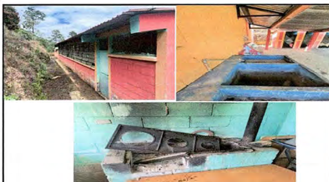
Foto 3: Modulo 1: Reparación de banqueta de concreto, sustitución de pila y Sustitución de Estufa rural(completa) incluye chimenea y plancha de metal.
