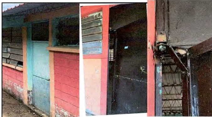
Foto 4: Modulo 1: Mantenimiento a puertas de metal (reparación, lijado y pintado)
