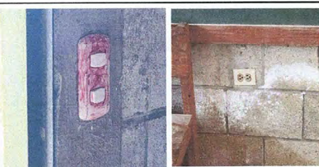
Foto 4: Modulo #1, Sustitucion de Toma Corrientes e Interruptores Dobles.
