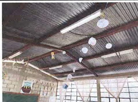
Foto 2: Modulo #1, Mantenimiento a estructura de soporte de Metal, Reparacion del Cableado Electrico y Sustitucion de Lamparas Tipo Led.
