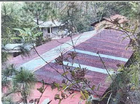
Foto1: Modulo #1, Sustitución de Lamina, por lamina troquelada aluzinc calibre 26 y Sustitución de Capote.
