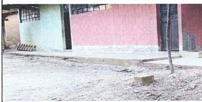
Foto 8: Modulo#1, Sustitucion de Torta de Concreto Por piso Ceramico Antideslizante
