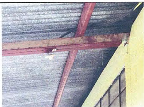
Foto 3: Modulo #1, Sustitucion de Focos Ahorradores
