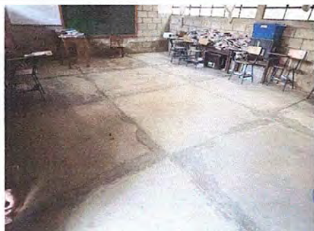
Foto 7: Modulo#1, Sustitucion de Piso Cocreto por Piso Ceramico.
