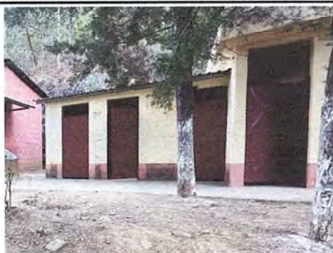
Foto 9: Modulo #2, Mantenimiento a estructura de Puertas de Metal
