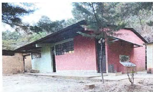
Foto 5: Modulo #1 Instalacion de Canal y Bajada de Agua Pluvial.
