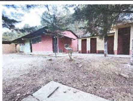
Foto 10: General, Pintura de Muros Interior y Exterior.
