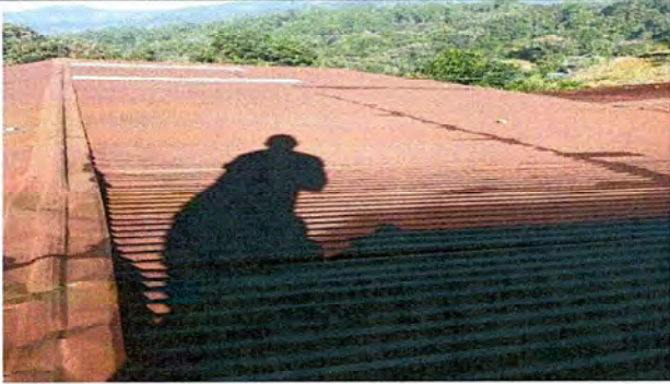
FOTO 1 MODULO 1 SUSTITUCION DE LAMINA TROQUELADA
