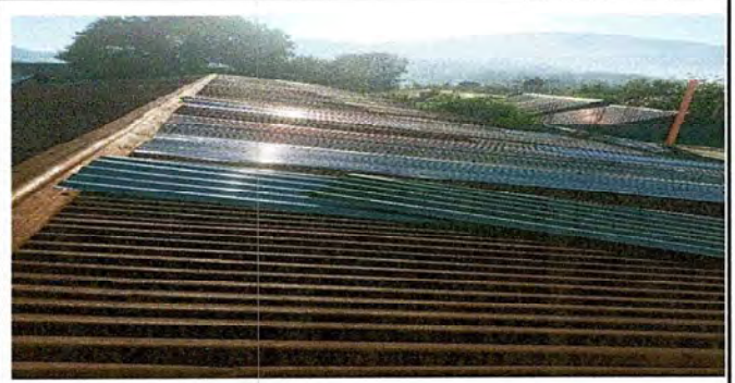
FOTO 2 MODULO 1 SUSTITUCION DE LAMINA TROQUELADA
