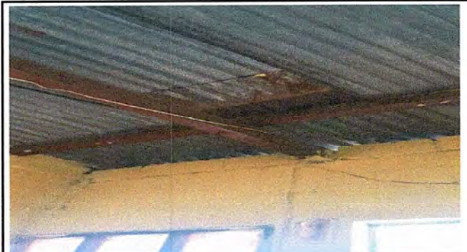
FOTO 4 MODULO 1 SUSTITUCION DE LAMINA TROQUELADA
