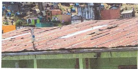
Foto 5: Sustrucción de lamina, por lámina troquelada aluzinc calibre 26.
