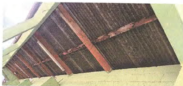
Foto2: Sustrucción de estructura de soporte de madera, por metal.
