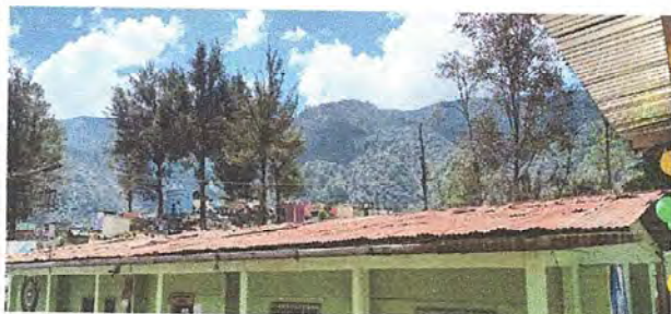
Foto 3: Sustrucción de lamina, por lámina troquelada aluzinc calibre 26.
