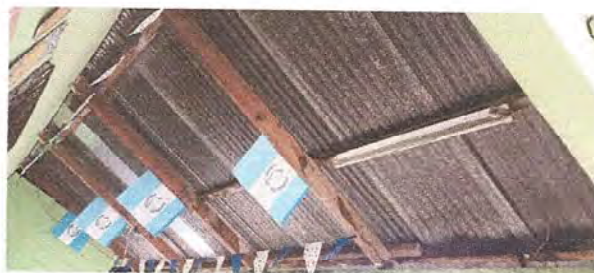
Foto 4: Sustrucción de estructura de soporte de madera, por metal.
