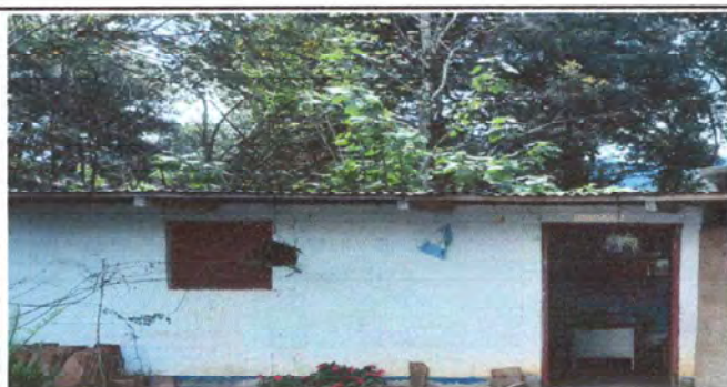
Modulo 1. Foto 3. Sustitución de lámina por lámina troquelada aluzinc calibre 26.
