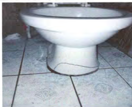
Modulo 1. Foto 4. Sustitución de inodoro.
