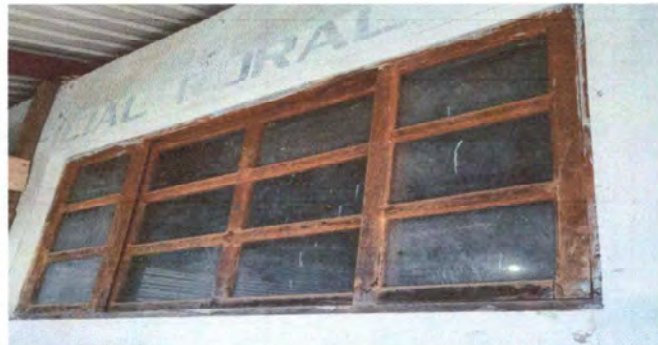
Modulo 1. Foto 2. Sustitución de ventanas de madera por metal más vidrio
