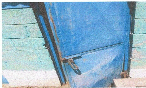
Foto4 Módulo 1: sustitución de puertas en servicios sanitarios.
