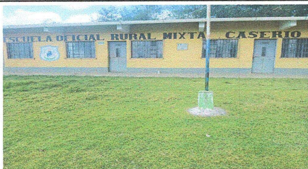
Foto1 Módulo 1: sustitución de balcones
