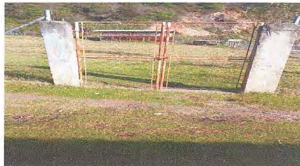
FOTO 14 MURO PERIMETRAL: SUSTITUCIÓN DE PORTON DE METAL DE 4X4
