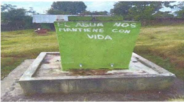
FOTO 7 CISTERNA DE CONCRETO: SUSTITUCIÓN DE AZULEJO
