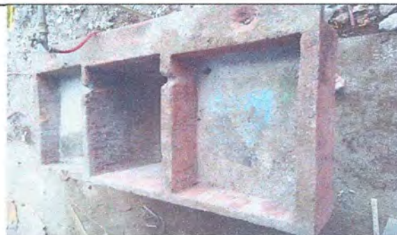
FOTO 6 COCINA: SUSTITUCIÓN DE PILA DE CEMENTO DE DOS LAVADEROS.
