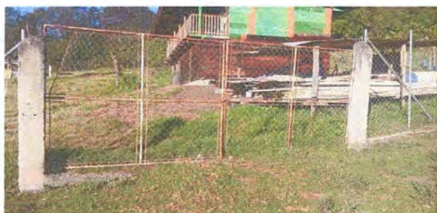
FOTO 13 MURO PERIMETRAL: SUSTITUCIÓN DE PORTON DE METAL DE 8X4
