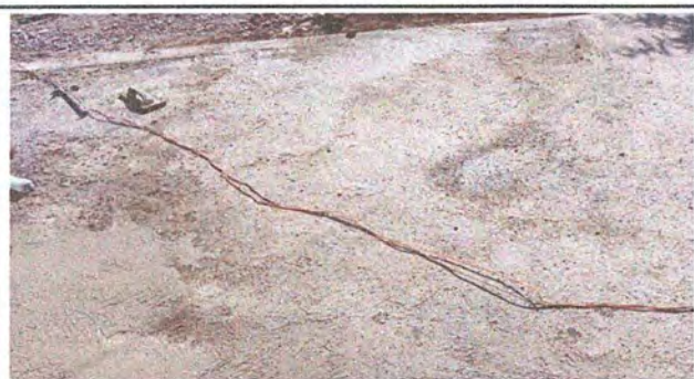
FOTO 3 COCINA SUSTITUCIÓN DE PISO DE TORTA DE CONCRETO POR PISO CERAMICO.
