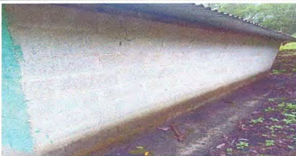
FOTO 9 BAÑOS: SUMINISTRO E INSTALACIÓN DE CANALES DE PVC, BAJADAS DE AGUA PLUVIAL Y PESCANTES.
