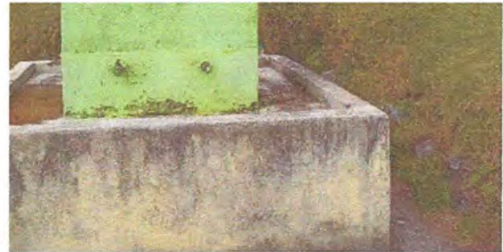
FOTO 8 CISTERNA DE CONCRETO: SUSTITUCIÓN DE LLAVE DE CHORRO.
