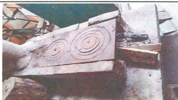
FOTO 4: COCINA: SUSTITUCIÓN DE ESTUFA RURAL COMPLETA.
